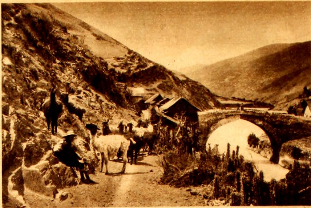
EL PUENTE DE PAUCARTAMBO, CONSTRUIDO POR UNA SUSPICACIA DE CARLOS III.
