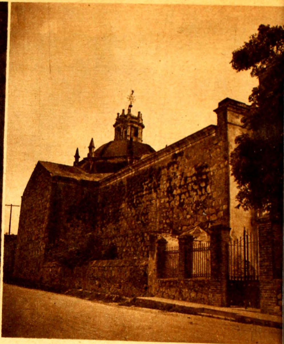
FACHADA DEL SUR. — COSTADO DE LA NAVE.
