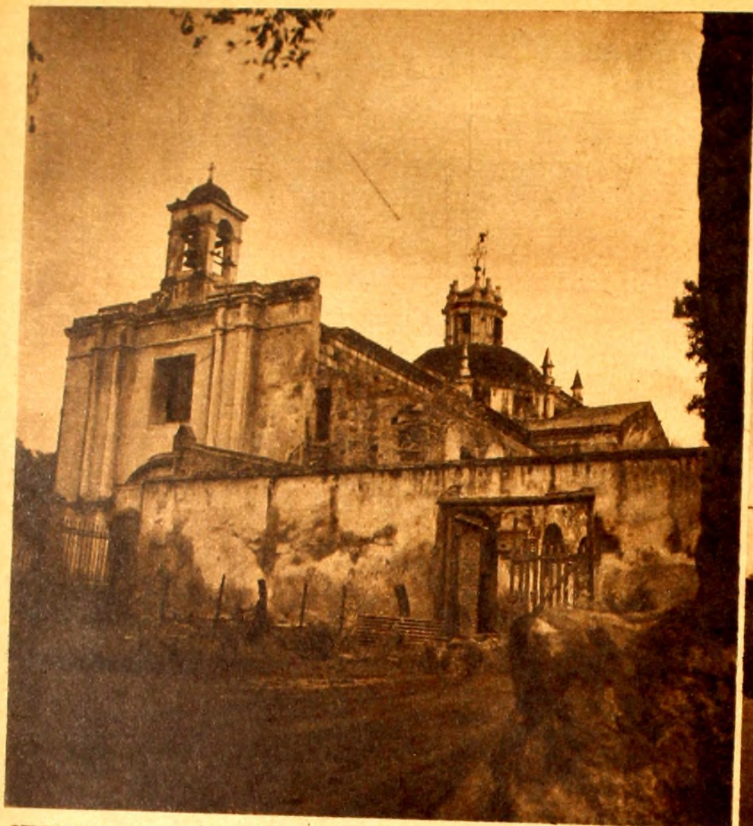
REDUCCION JESUITICA DE SAN ISIDRO. — FACHADA DE LA NAVE Y DEL CLAUSTRO.
