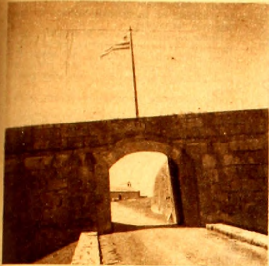
PORTON DE ENTRADA A LA FORTALEZA, Y AL FONDO, LO QUE FUERA CAPILLA.
