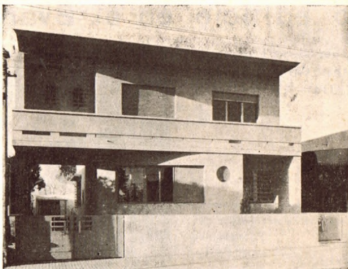
Fachada del inmueble situado en Boulevard Propios
