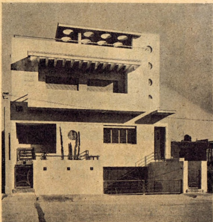
El elegante edificio dirigido por el arquitecto Juan C. Siri.
