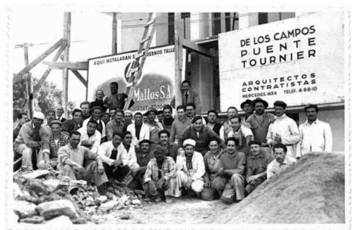
Personal de obra y capataces de la empresa.
