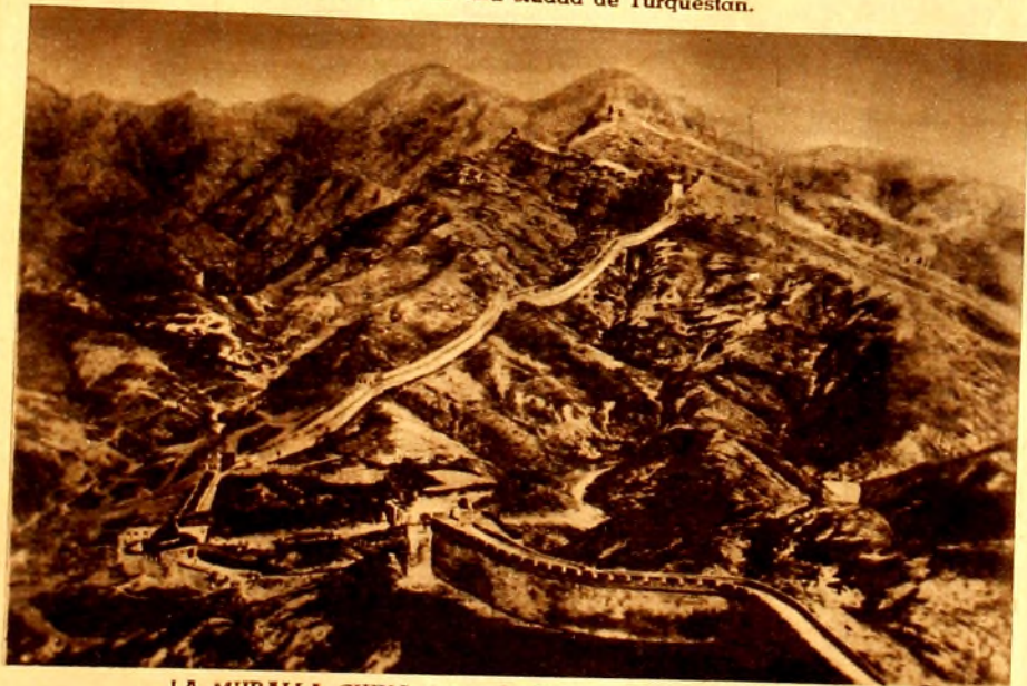
LA MURALLA CHINA cerca de Kalgan (Mongolia interior).
