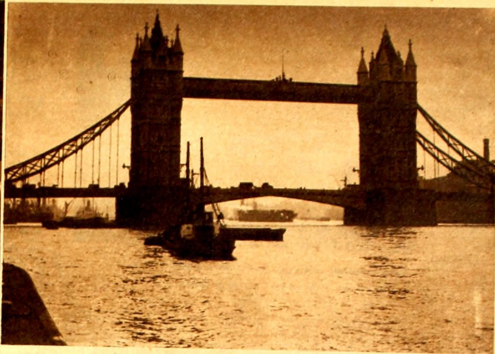
PUENTE DE LA TORRE DE LONDRES, SOBRE EL TAMESIS.
