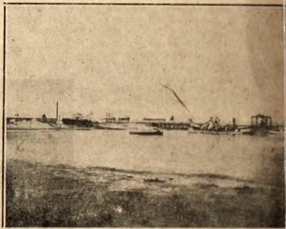
PUERTO «LA PALOMA», obra iniciada y en que se han gastado 800.000 pesos más o menos, y que ahora está casi abandonada.
