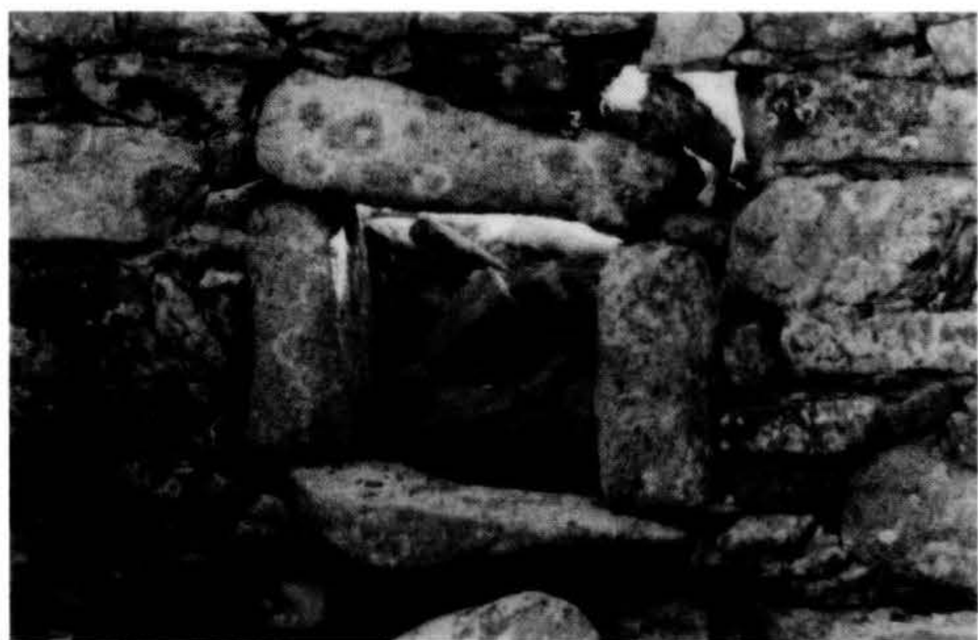
Detalle de muro y abertura con dintel de piedra
