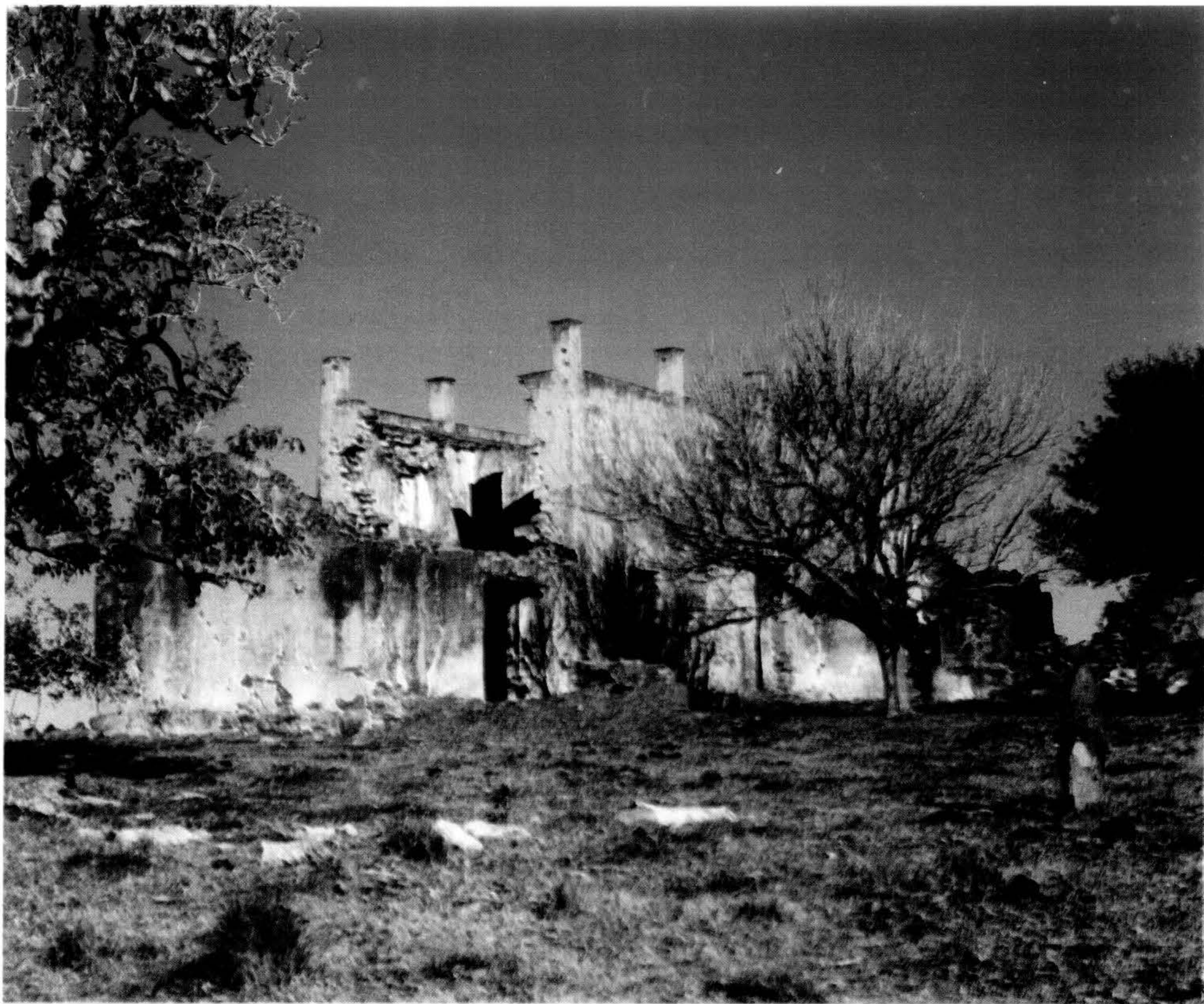
AZOTEA DE CABRERA: TOMA DESDE EL PATIO
