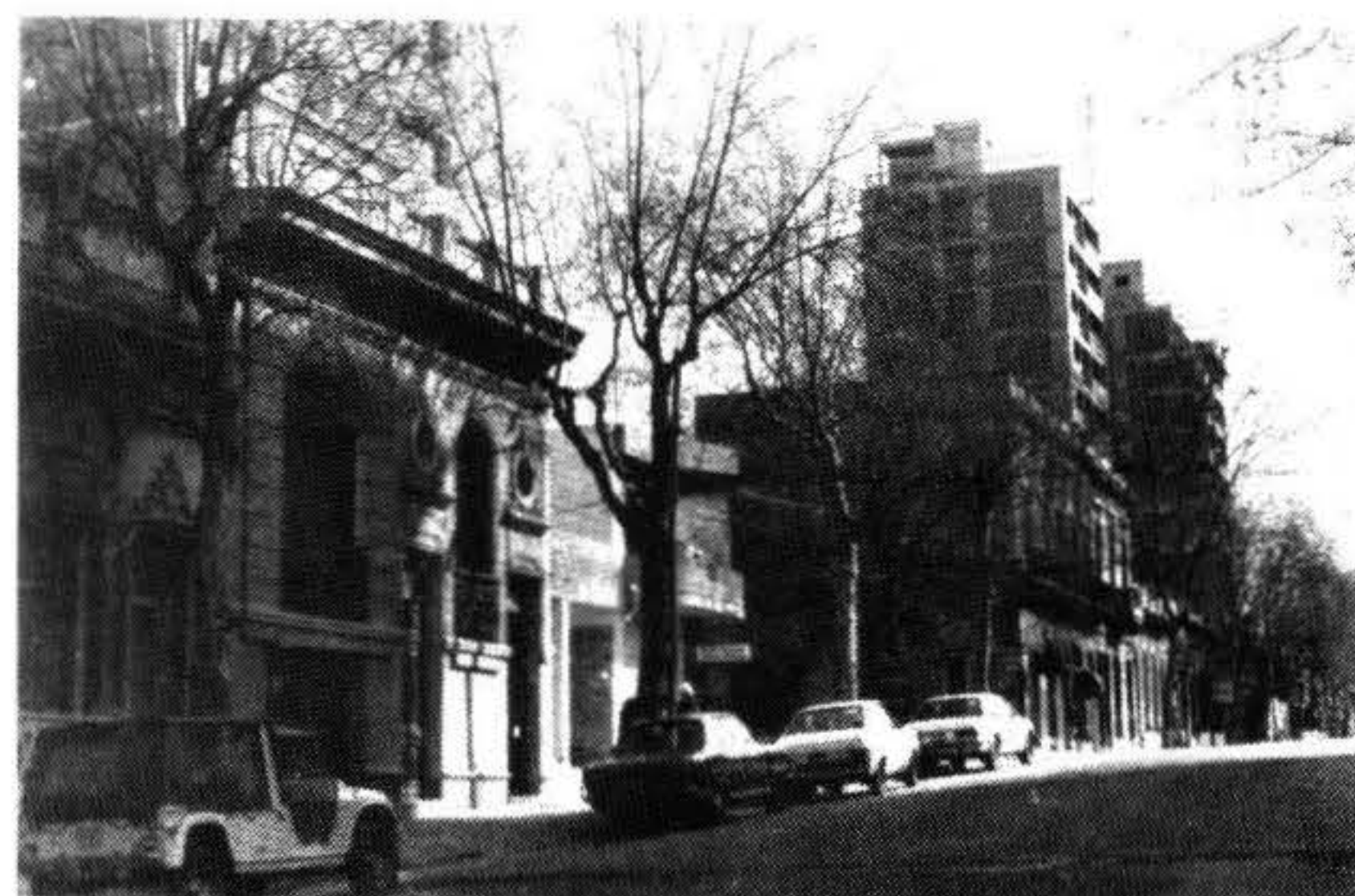
Calle Maldonado: La ruptura de escala y alineación de las sustituciones más frecuentes no logran conformar una alternativa coherente para el lento proceso de transformación urbana.
