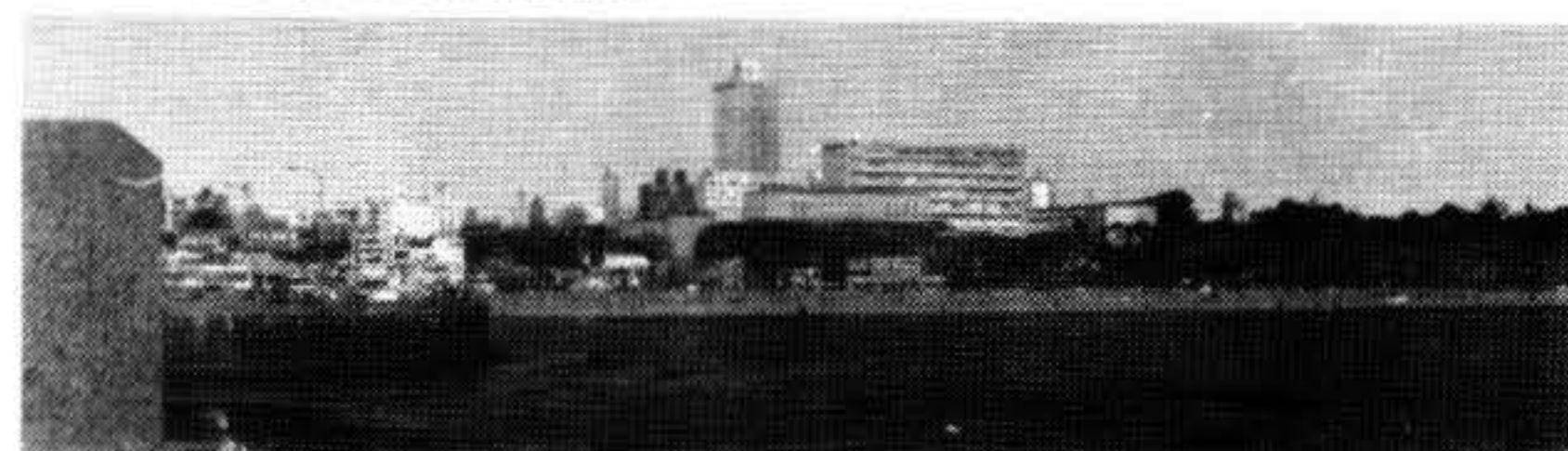
La promulgación de la ordenanza de sobreelevados con carácter general para toda el área urbana ocasionó tremendas distorsiones al paisaje urbano.
