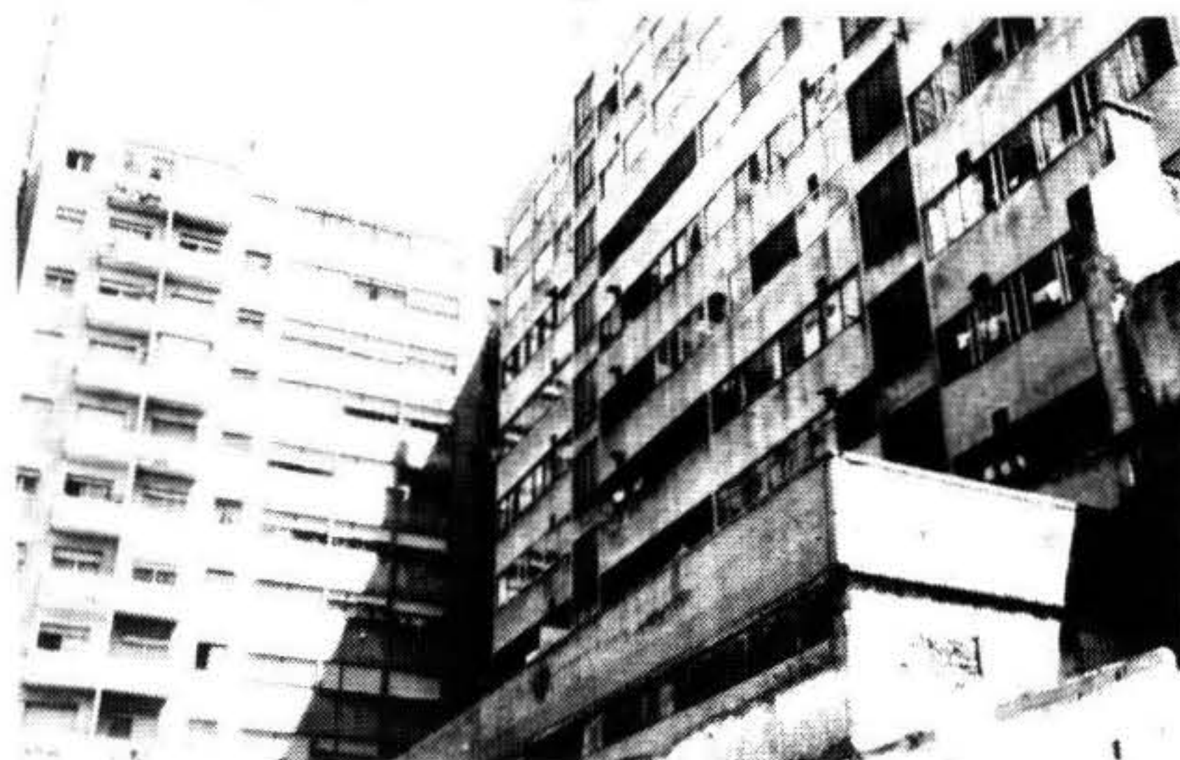
Los "centros de manzana": Su conformación aún no ha podido ser reglamentada, lo que posibilitaría indudables mejoras en las condiciones de habitabilidad de los edificios en altura.
