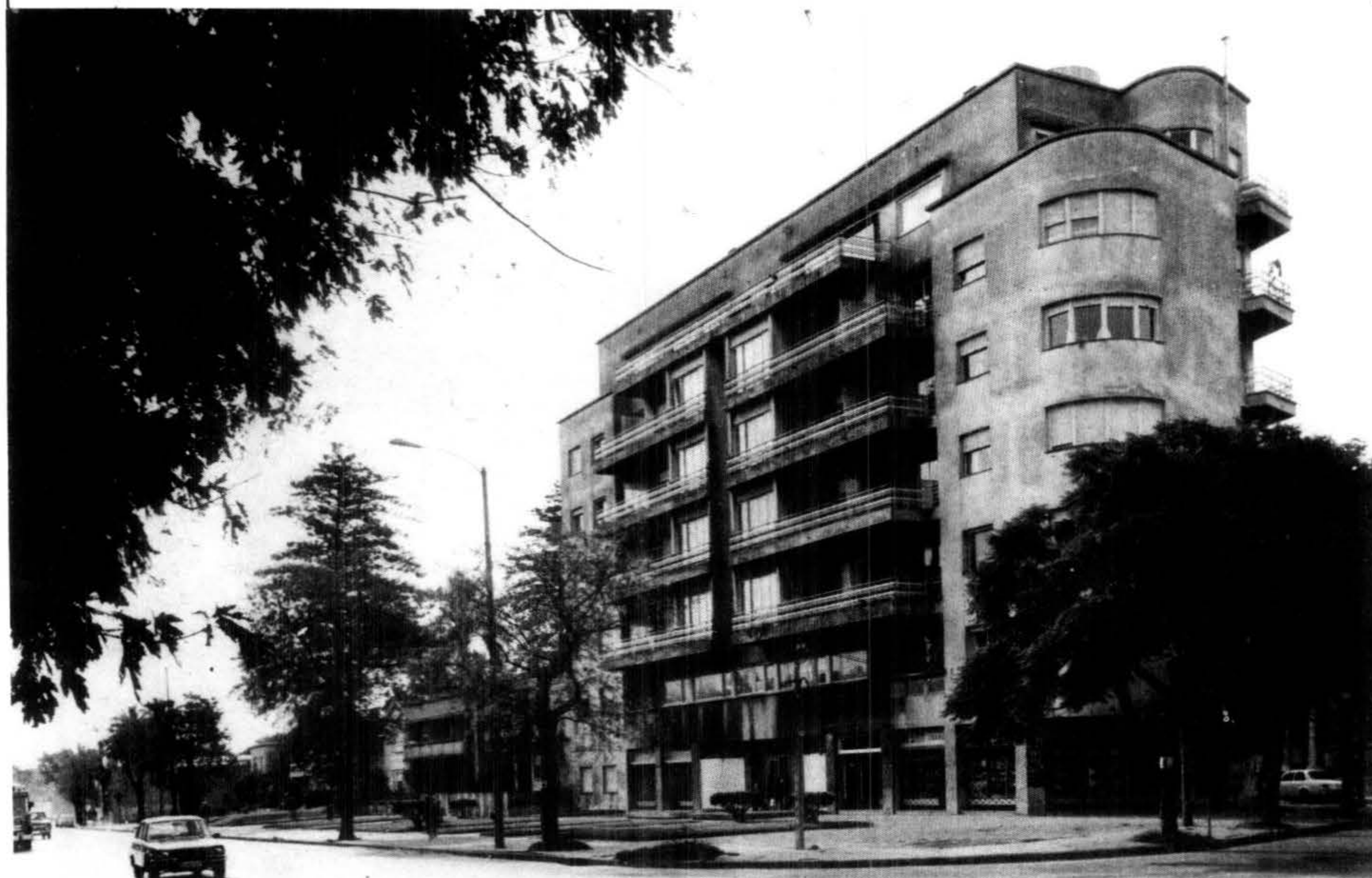
Edificio en Agraciada y Buschental
