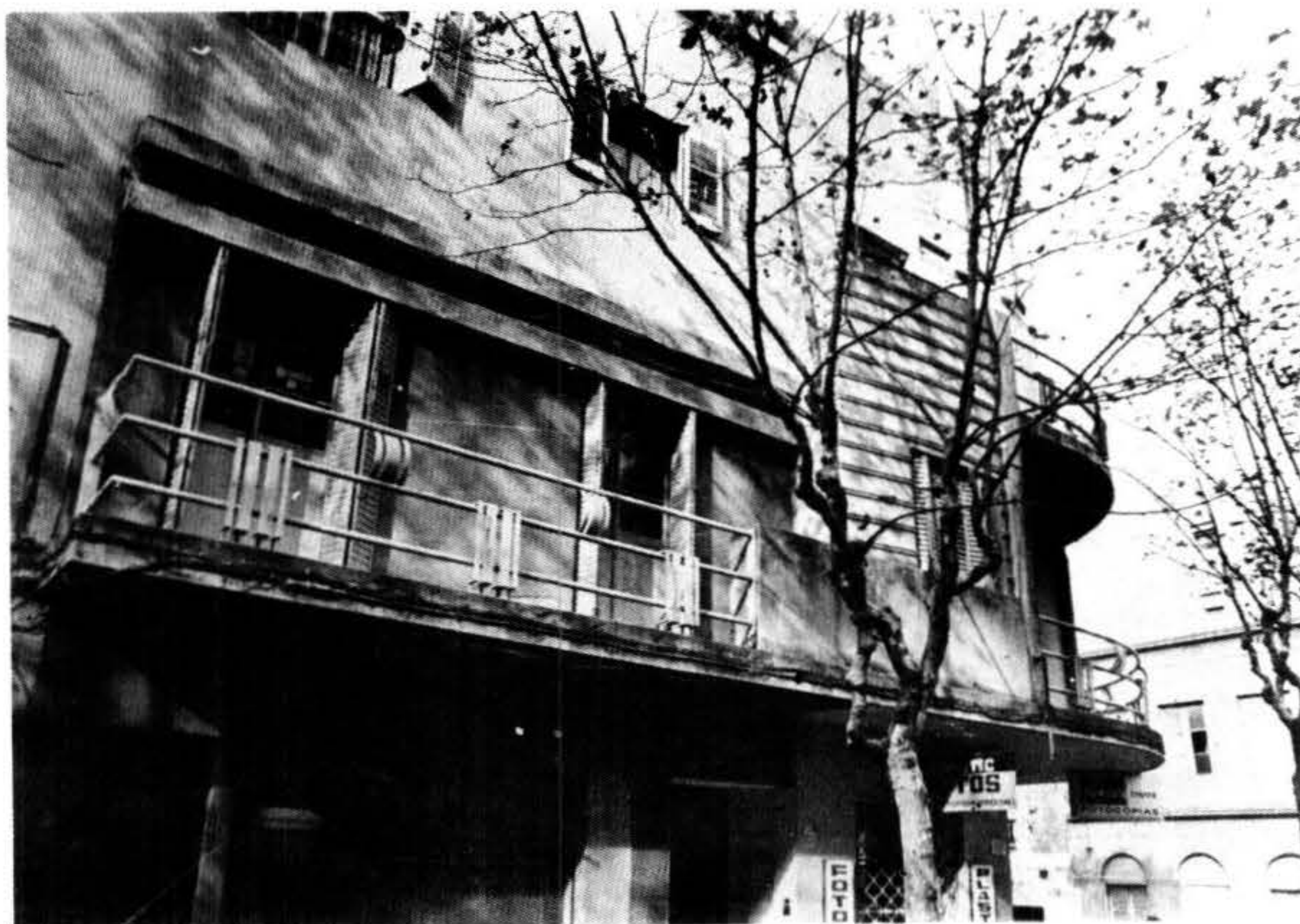
Edificio de renta, calle Ejido N° 1202 esq. Canelones, Montevideo (1933).
