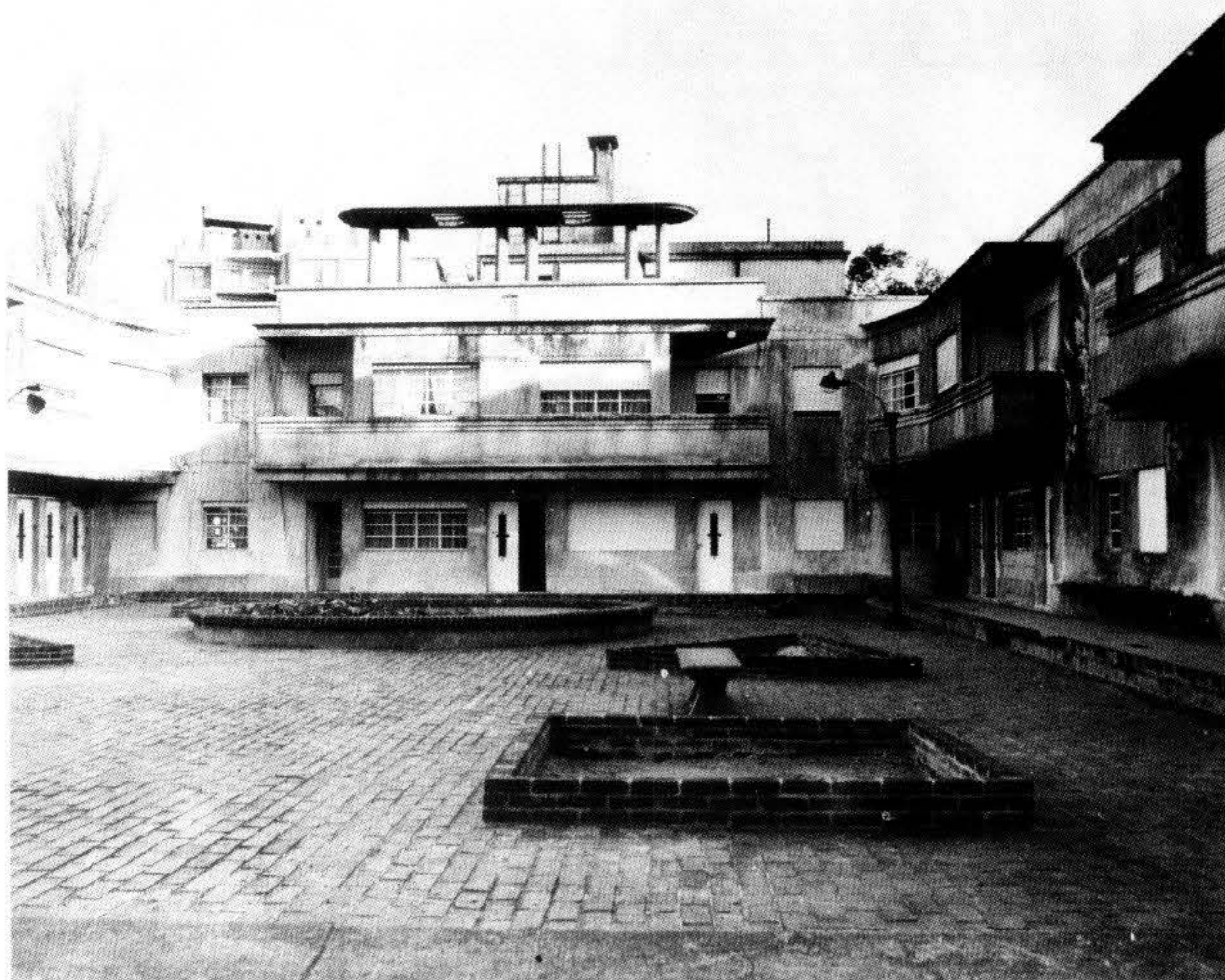
Conjunto de viviendas en calle Lamas
