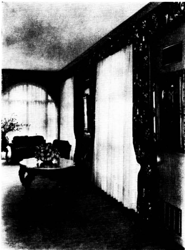
Termoductos instalados en la residencia del Sr. Carlos Scheck
