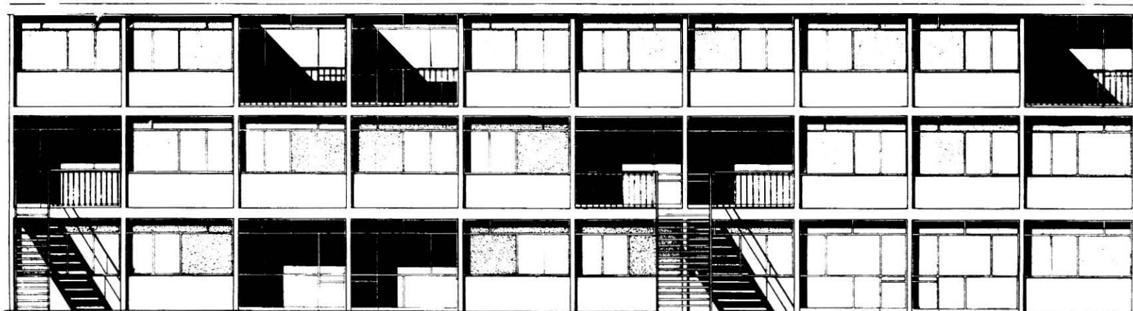
Fachada sobre senda peatonal
