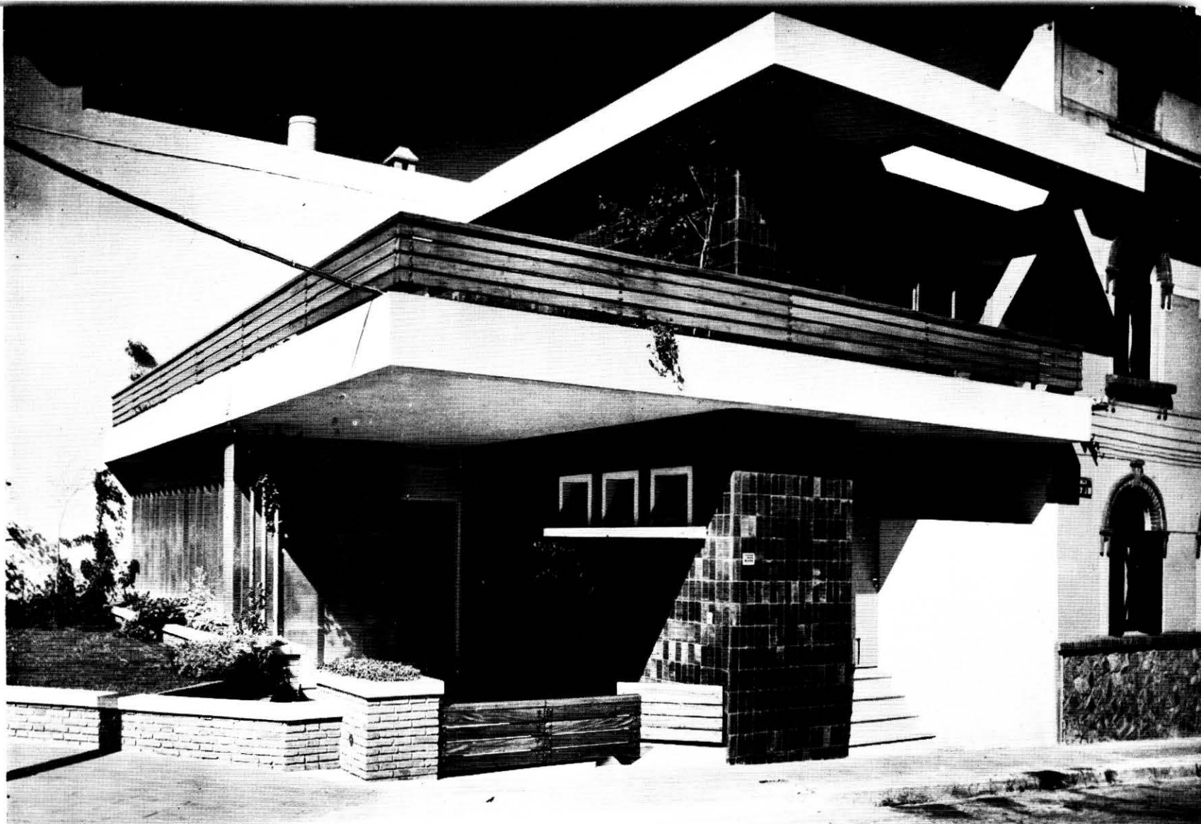
VISTA DESDE LA CALLE LAPIDO (POCITOS)
