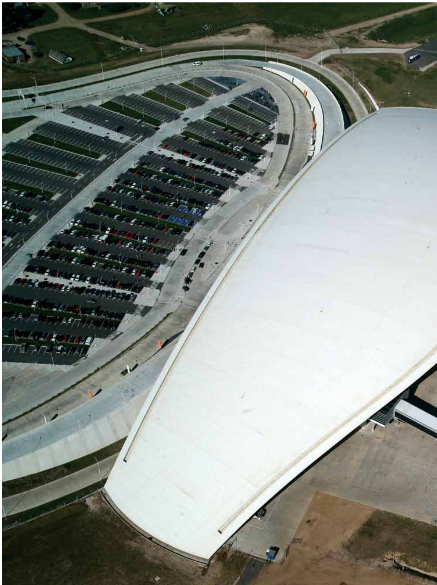
Nueva terminal aérea. Infraestructura de alta calidad y belleza. New airport terminal. High quality and beauty infrastructure. Montevideo.
