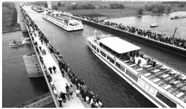
Figura 15. Puente Acuífero. Elbe. Elbe Water Bridge.
