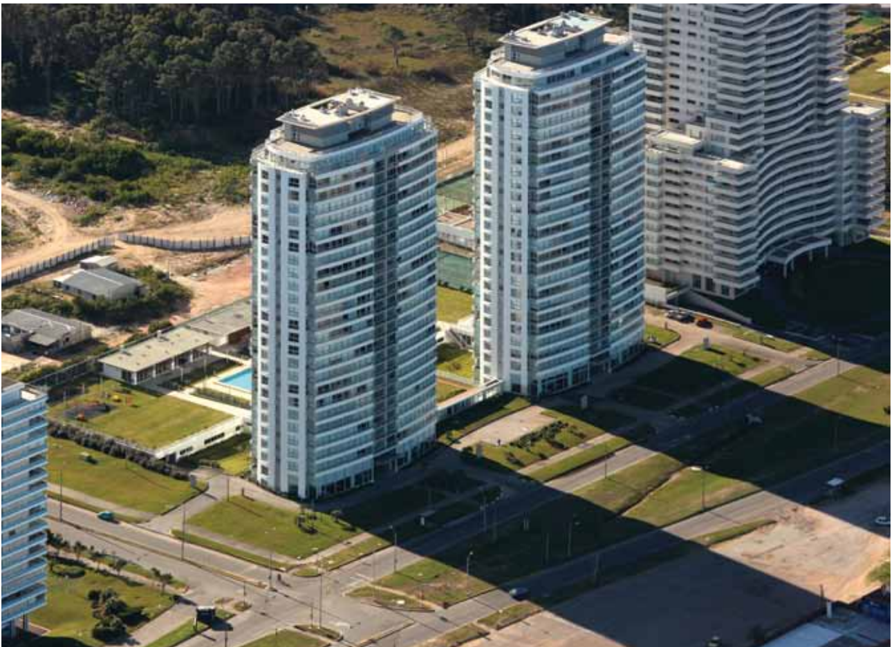
Nuevas torres macizas. New solid towers. Punta del Este.
