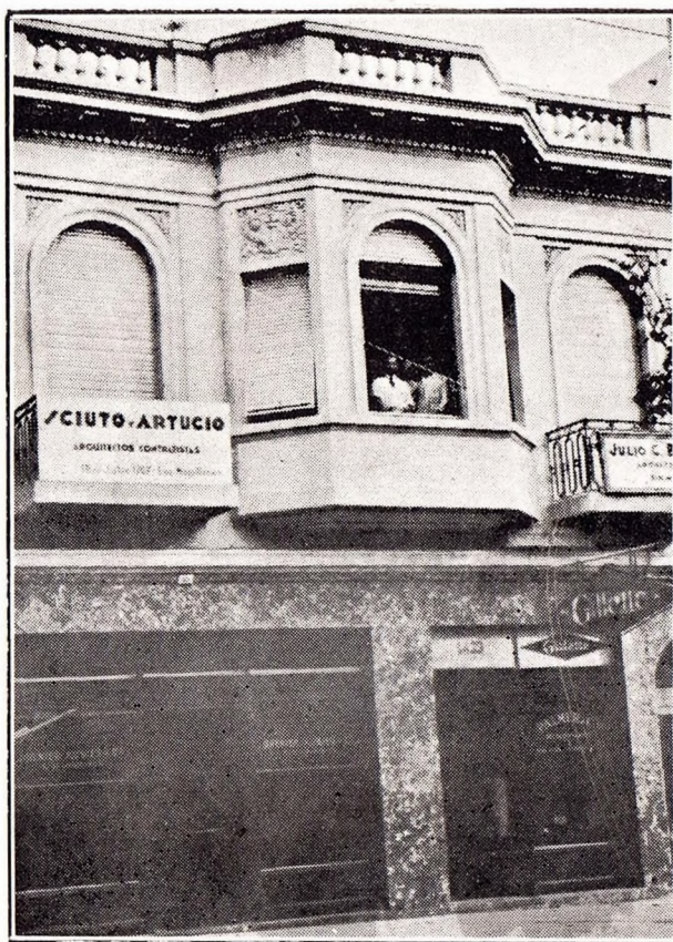
Vista del edificio totalmente terminado.
