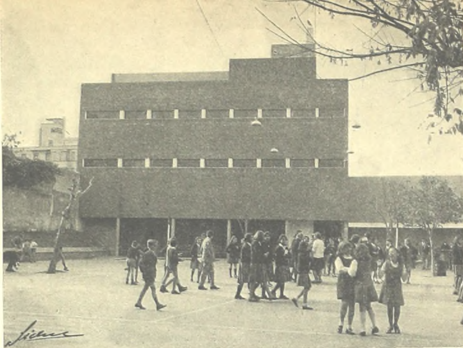
Desde el patio del Colegio la fachada sur presenta los dos niveles de vestuarios sobre el pórtico que regula la iluminación natural del gimnasio secundario y abriga el acceso al edificio de los alumnos.
