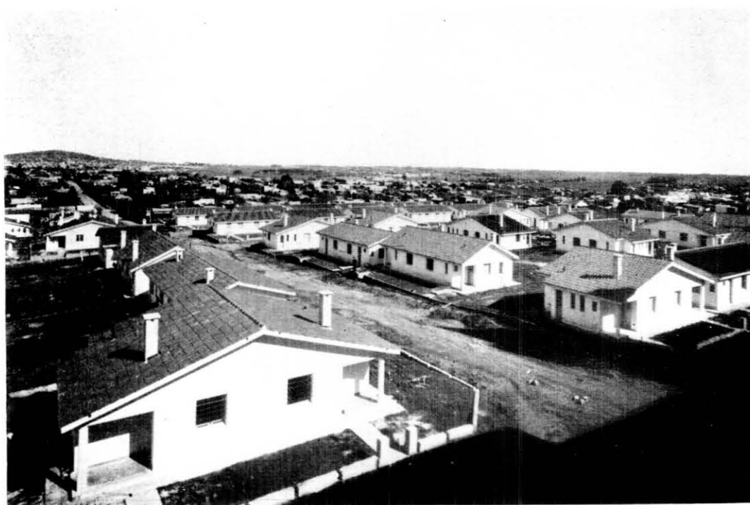
VISTA DE CONJUNTO DEL BARRIO Nº 1
