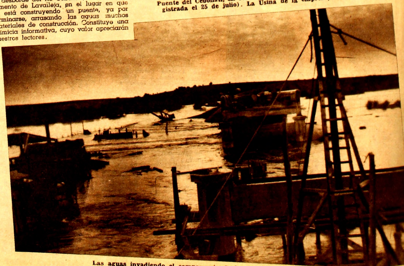
Las aguas invadiendo el campamento de la empresa constructora del puente.
