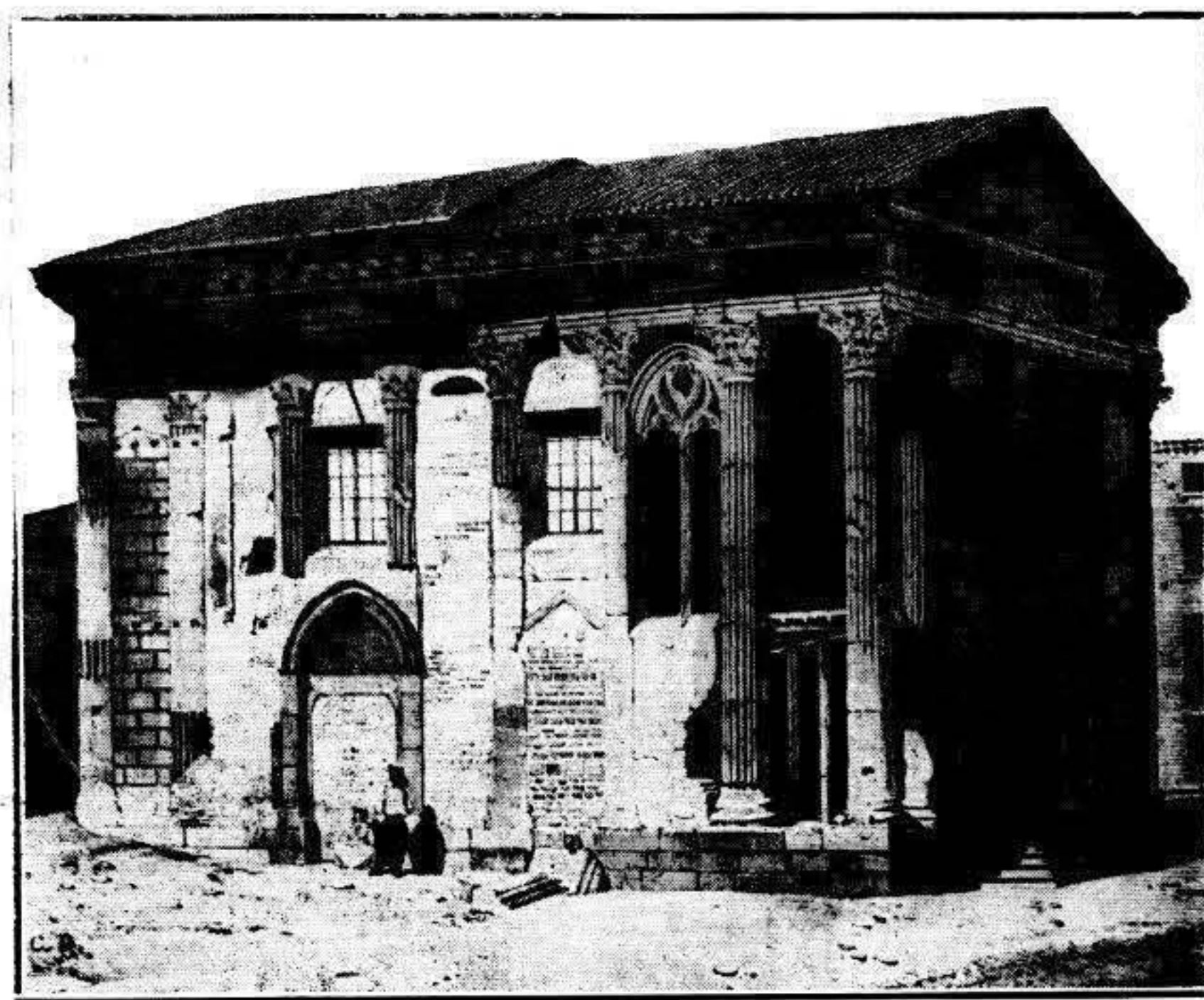
El templo de Vienne antes de ser restaurado
