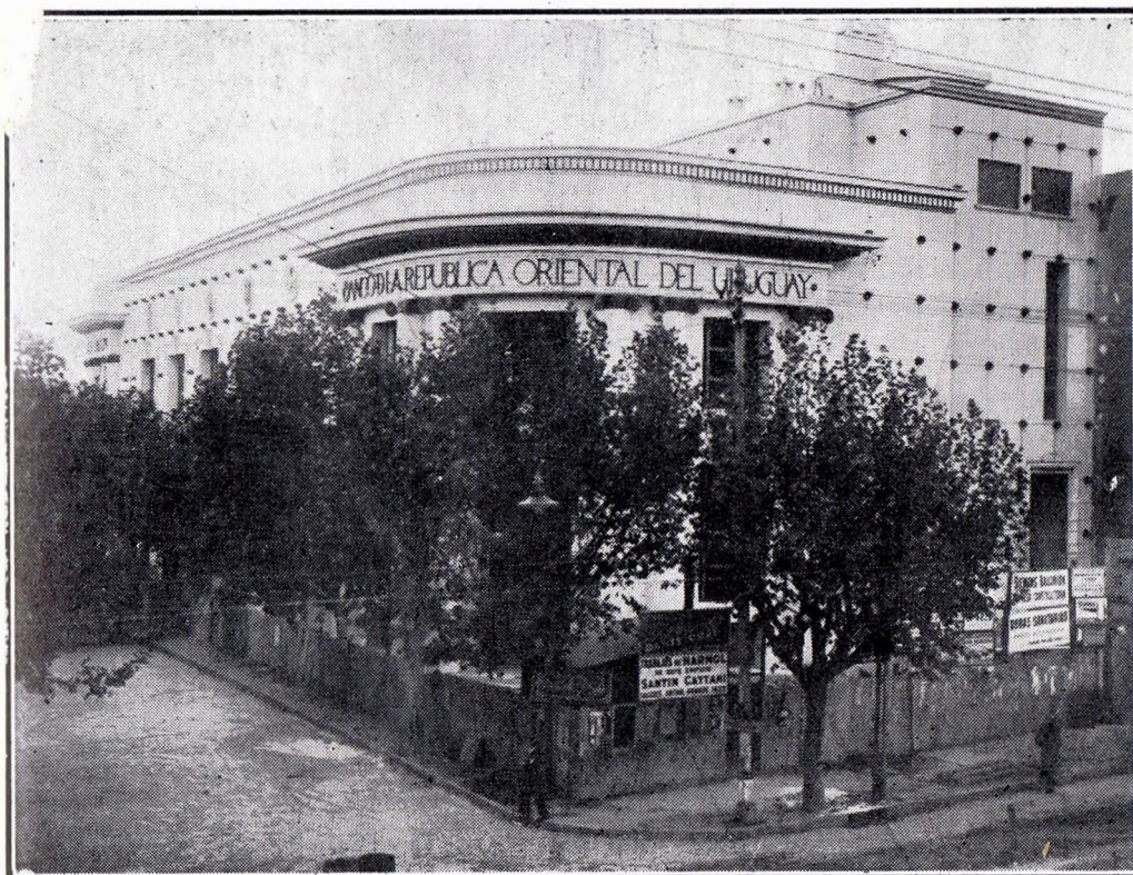
Vista de la nueva sucursal del Banco. Este edificio ha sido equipado con ascensores "OTIS"
