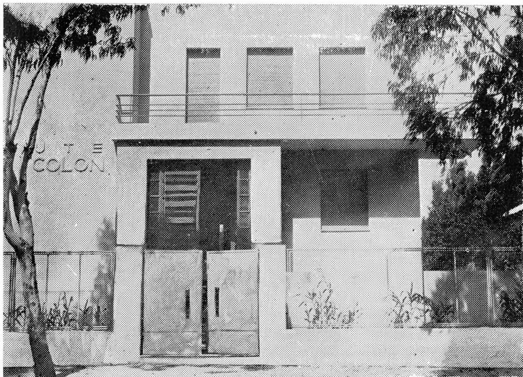
Vista del edificio situado en la calle Calderón de la Barca y Carve
