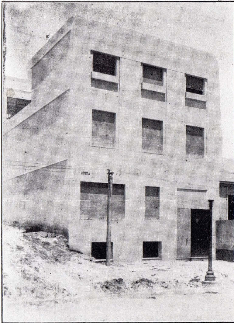
Fachada de la Central Telefónica Pocitos
