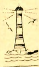
FARO CABO POLONIO. — (Situado en Cabo Polonio en el Dpto. de Rocha). — El primer faro que encuentran los navegantes en su recalada al Plata. La torre es de piedra de sillería y el faro erigido en la parte más alta y rocosa del Cabo Polonio, se eleva a 39,7 metros sobre el nivel del mar. Proyecta un destello de luz blanca cada 12 segundos y tiene un alcance luminoso de 18 millas. (33.336 metros). Es radiofaro y funciona como tal cuando la niebla cubre el horizonte visible desde el faro, emitiendo al espacio una señal característica cada 10 minutos. Con esta señal y con los modernos aparatos de radiogoniometría, los buques pueden situarse aún cuando naveguen en medio de una niebla cerrada.
