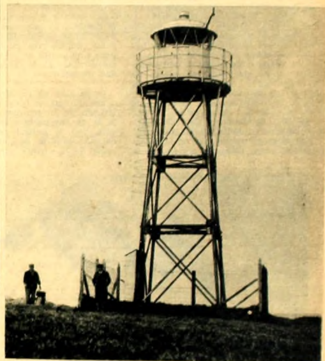
FAROLETA PUNTA NEGRA. — Situada en la extremidad de la Punta Negra, en el Dpto. de Maldonado. — Faroleta automática, colocada en la parte superior de una armazón de hierro pintada de blanco, que se eleva 20 metros sobre el nivel del mar. Proyecta un grupo de destellos blancos cada 9 segundos con un alcance luminoso de 11,8 millas (21.853 metros).
