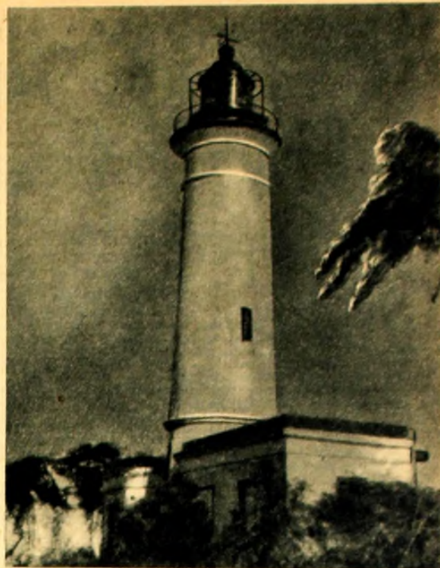
FARO FARALLON. — (Situado en el centro de la Isla de Farallón, al W. de la ciudad de Colonia). — Torre circular de mampostería con una altura de 26,3 metros sobre el nivel del mar. Proyecta un grupo de destellos blancos cada 10 segundos con un alcance luminoso de 16 millas (29.632 metros).
