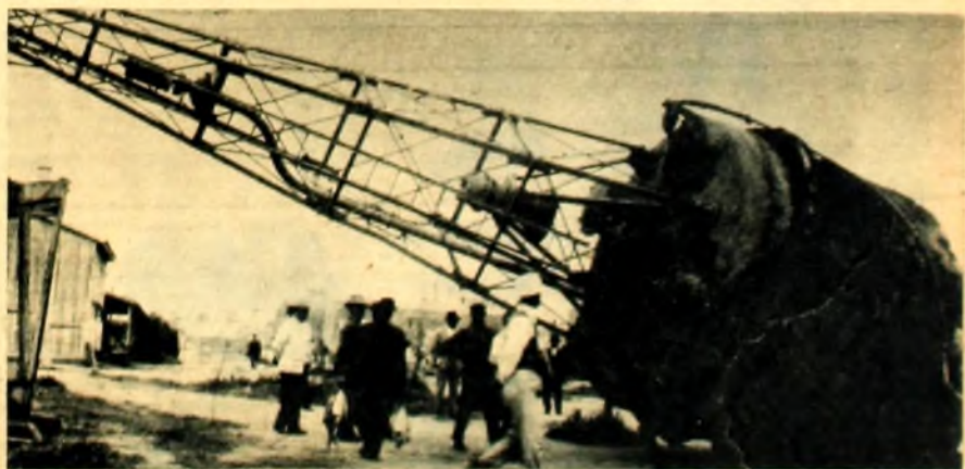
BOYA-FARO EJE DEL CANAL. — (Situada en el eje del canal de acceso al Puerto de Montevideo). — Boya pintada de negro con una altura de 9,7 metros. Proyecta un grupo de destellos blancos cada 5 segundos con un alcance luminoso de 11 millas (20.372 metros). Tiene silbato y campana aérea automática, que emite un sonido cada 10 segundos.
