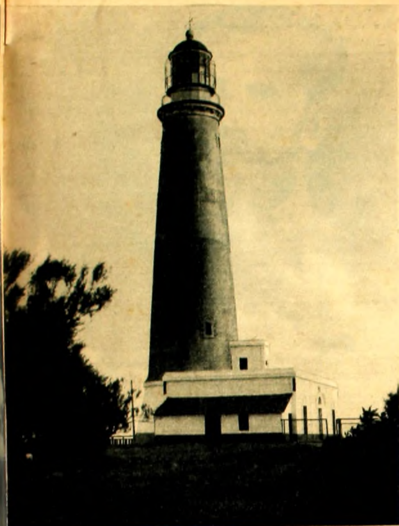
FARO CABO SANTA MARIA. — (Situado en el Cabo Santa María en el Dpto. de Rocha). — Colocado en la parte superior de una torre de sección circular, de mampostería que se eleva 42 metros sobre el nivel del mar. Proyecta un destello blanco cada minuto con un alcance luminoso de 19,5 millas (36.114 metros), exhibiendo en forma permanente una luz fija, también blanca, que se proyecta 10 millas (18.520 metros).
