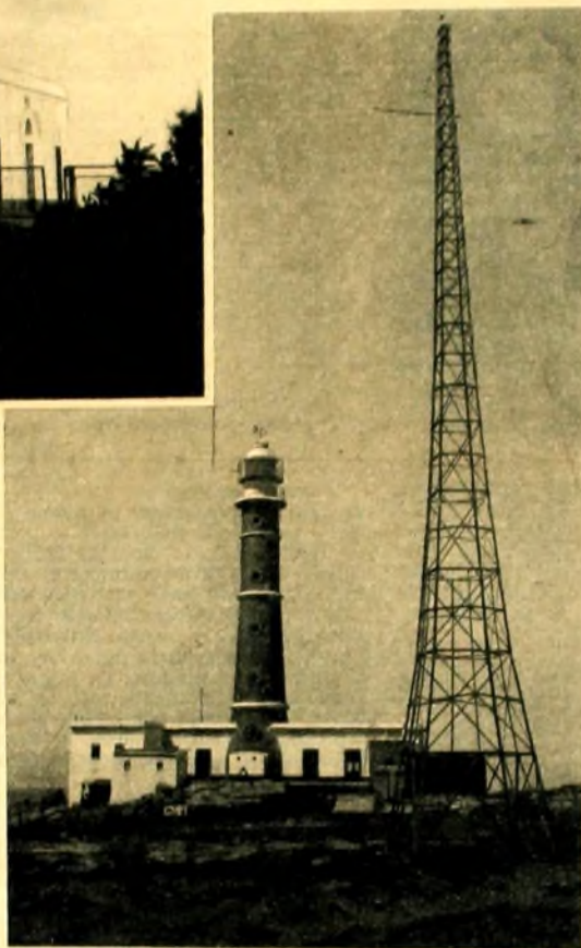
FARO CABO POLONIO. — (Situado en Cabo Polonio en el Dpto. de Rocha). — El primer faro que encuentran los navegantes en su recalada al Plata. La torre es de piedra de sillería y el faro erigido en la parte más alta y rocosa del Cabo Polonio, se eleva a 39,7 metros sobre el nivel del mar. Proyecta un destello de luz blanca cada 12 segundos y tiene un alcance luminoso de 18 millas. (33.336 metros). Es radiofaro y funciona como tal cuando la niebla cubre el horizonte visible desde el faro, emitiendo al espacio una señal característica cada 10 minutos. Con esta señal y con los modernos aparatos de radiogoniometría, los buques pueden situarse aún cuando naveguen en medio de una niebla cerrada.
