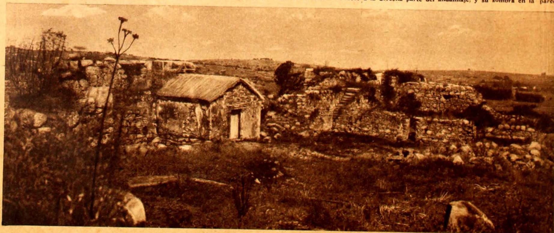
Una construcción y al fondo escalera que llevaba a las almenas
