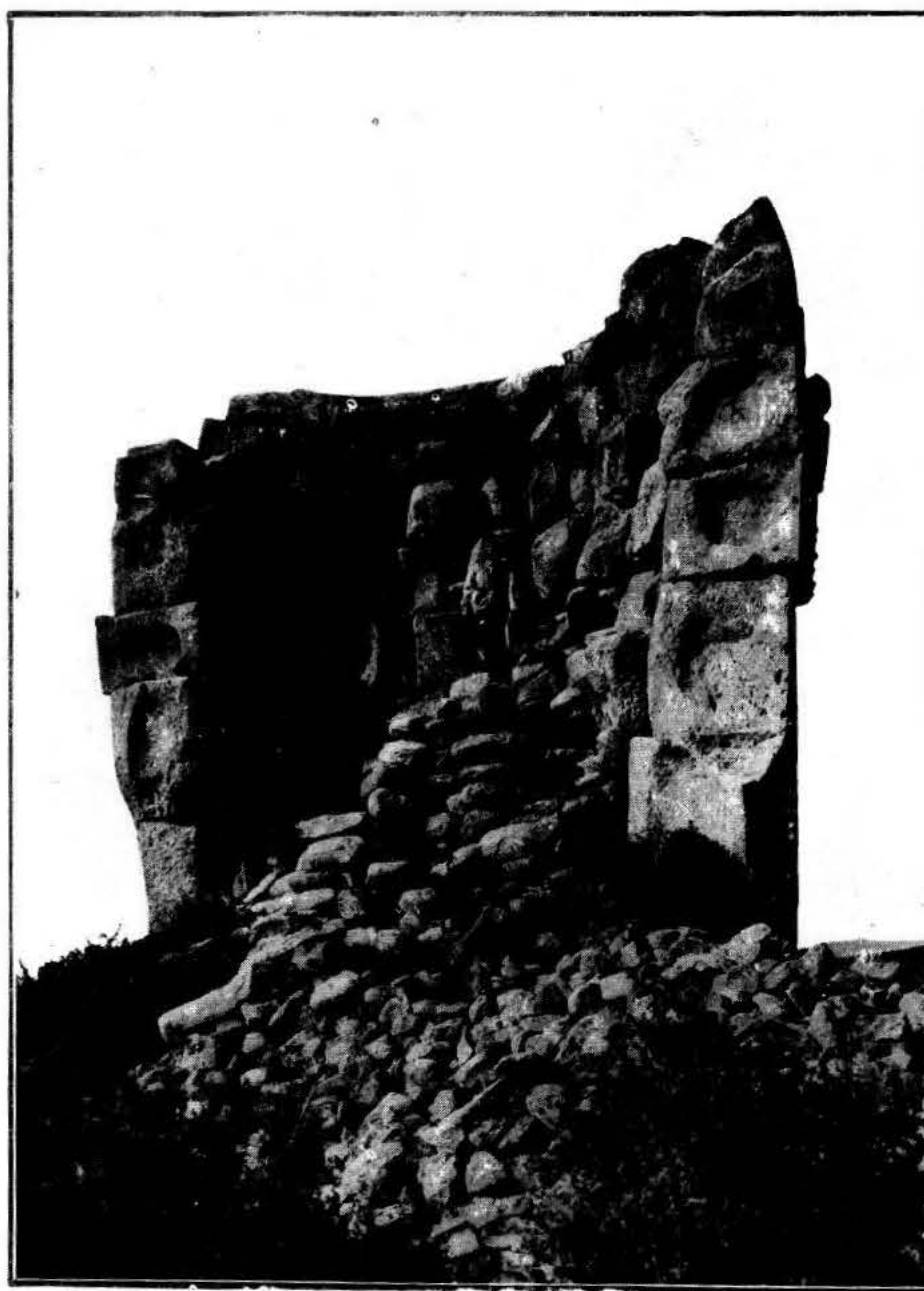
Técnica de construcción en Sillustani
