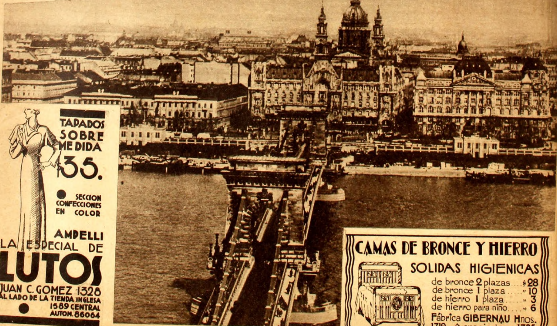
PONTE SUSPENDIDO DE CADENAS
