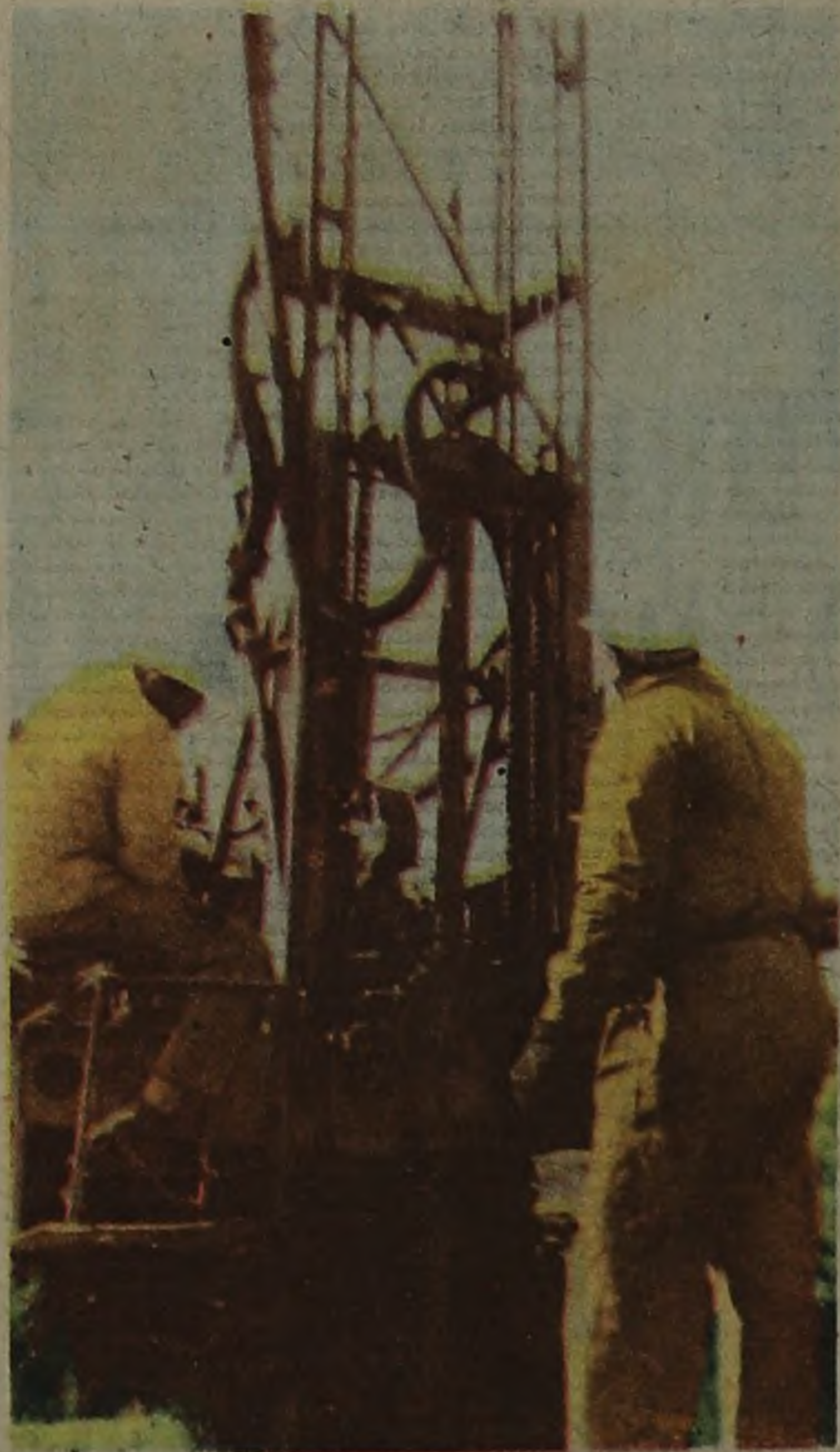
Trabajando en perforadora (Sdo. 1º OMAR DOS SANTOS).
