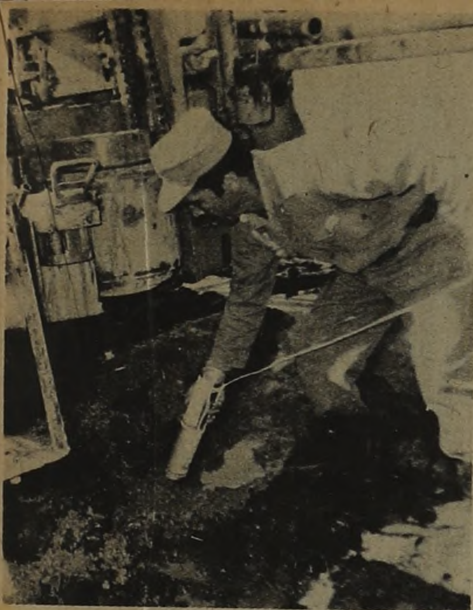
Colocación de dinamita en la perforación (Sdo. 1º WILMAN FERNANDEZ).
