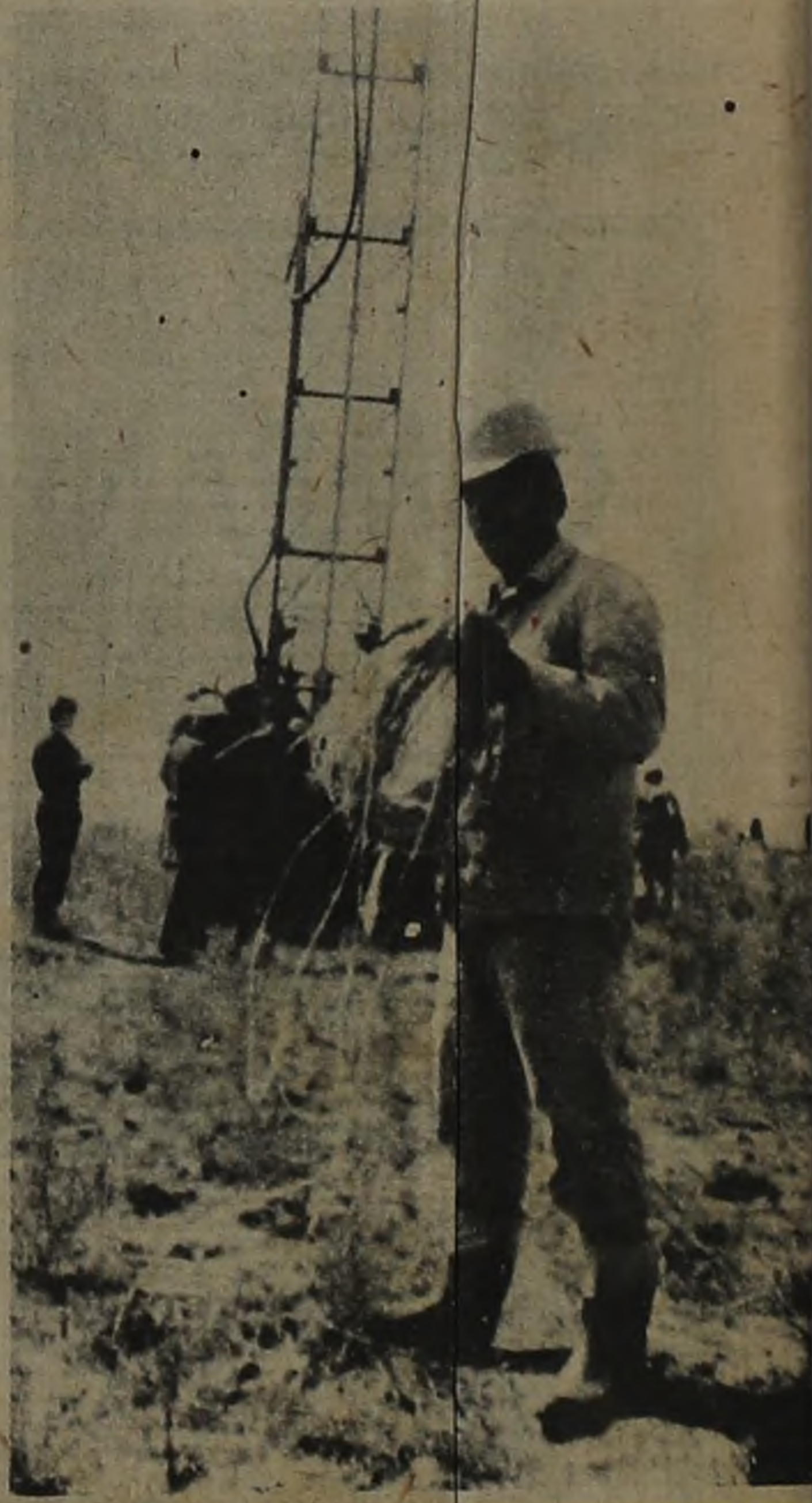
Tendido de cables para detonar las cargas (Sdo. 1º EVARISTO PASTOR).
