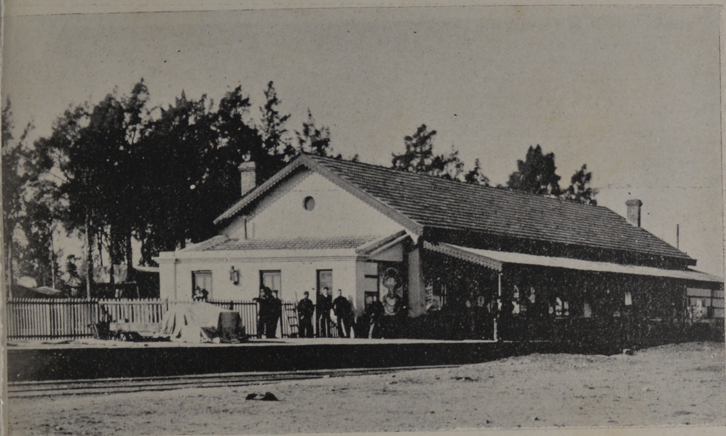
Santa Isabel.—Estación del Ferrocarril Central
