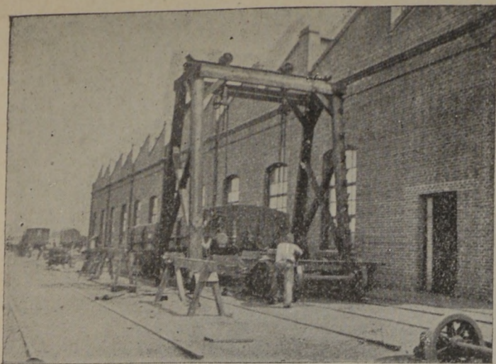
Operación de montaje.—Torno para la fabricación de las yantas de las ruedas de vagones
