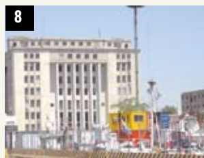
Edificio de la Administración Nacional de Puertos
