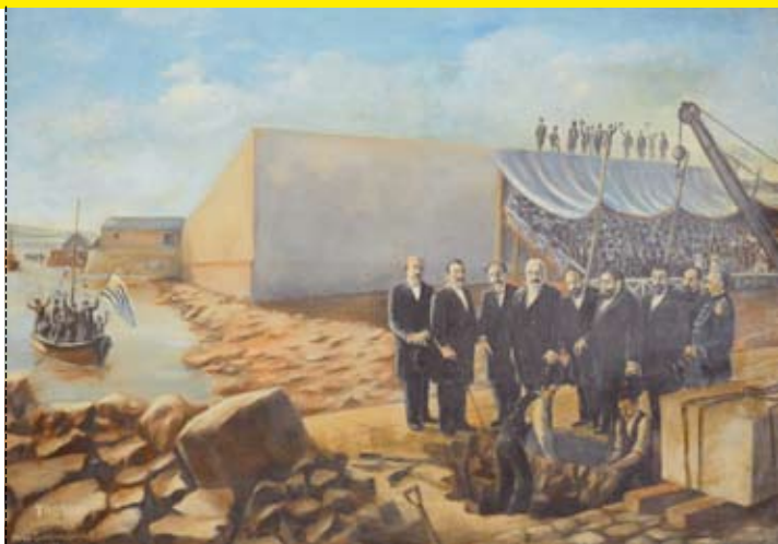
△ 18 de julio de 1901. Inauguración de las obras del Puerto de Montevideo. Presidente Juan Lindolfo Cuestas y sus ministros.
