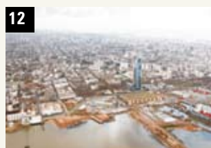
Central Batlle UTE, obra acceso Norte ANP
