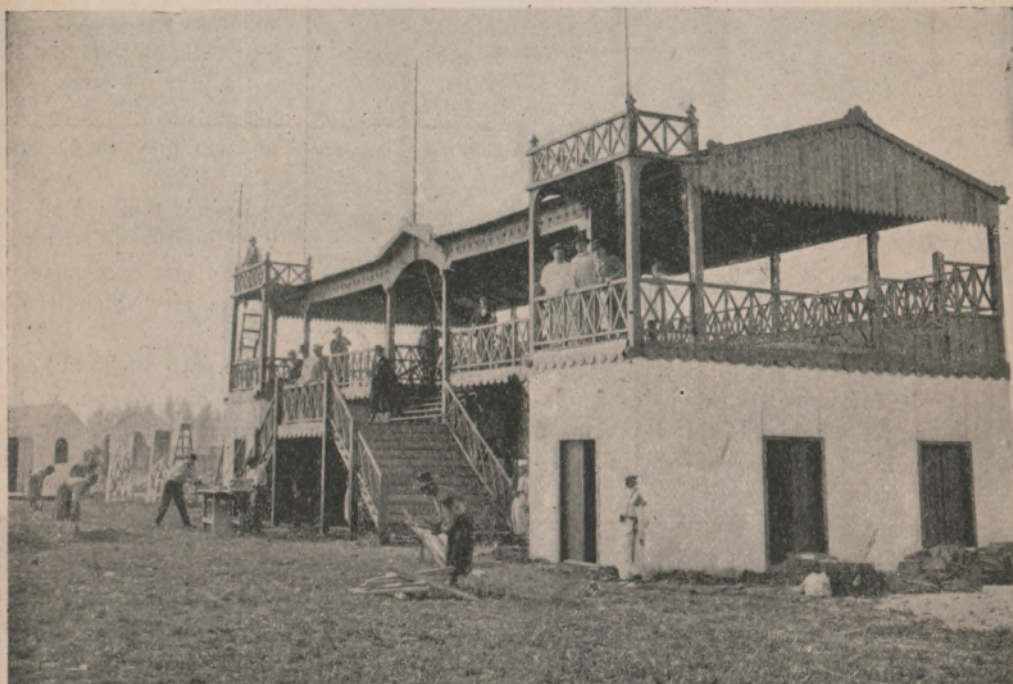
El pabellón central
