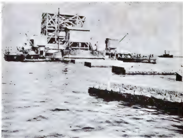
¿Aparato Atlas colocando las pilas sobre las cuales descansan los muelles A y B.
