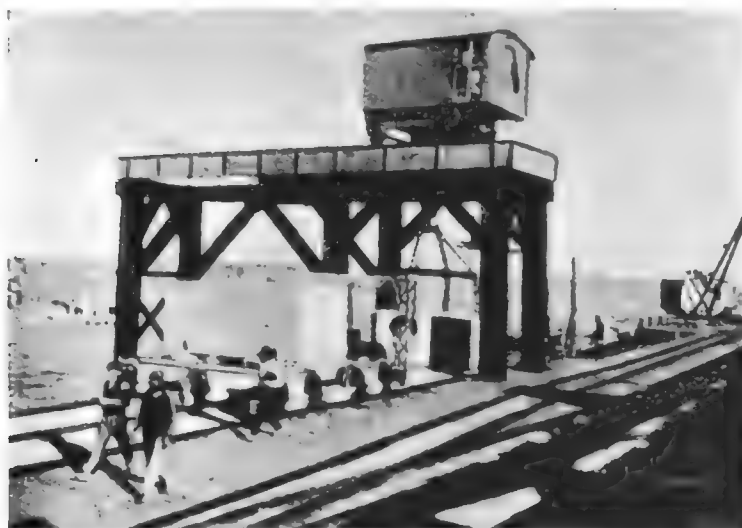
La Teja.—Puente para embarcar los grandes bloques
