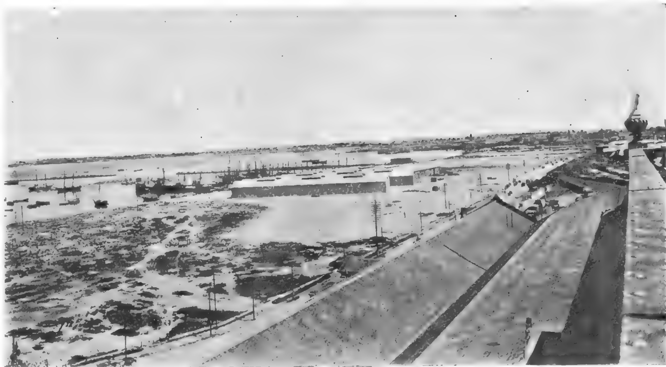
Terraplenes al Este de la bahía.—Cuarenta hectáreas ganadas al mar.—Depósitos de exportación y depósitos de inflamables
