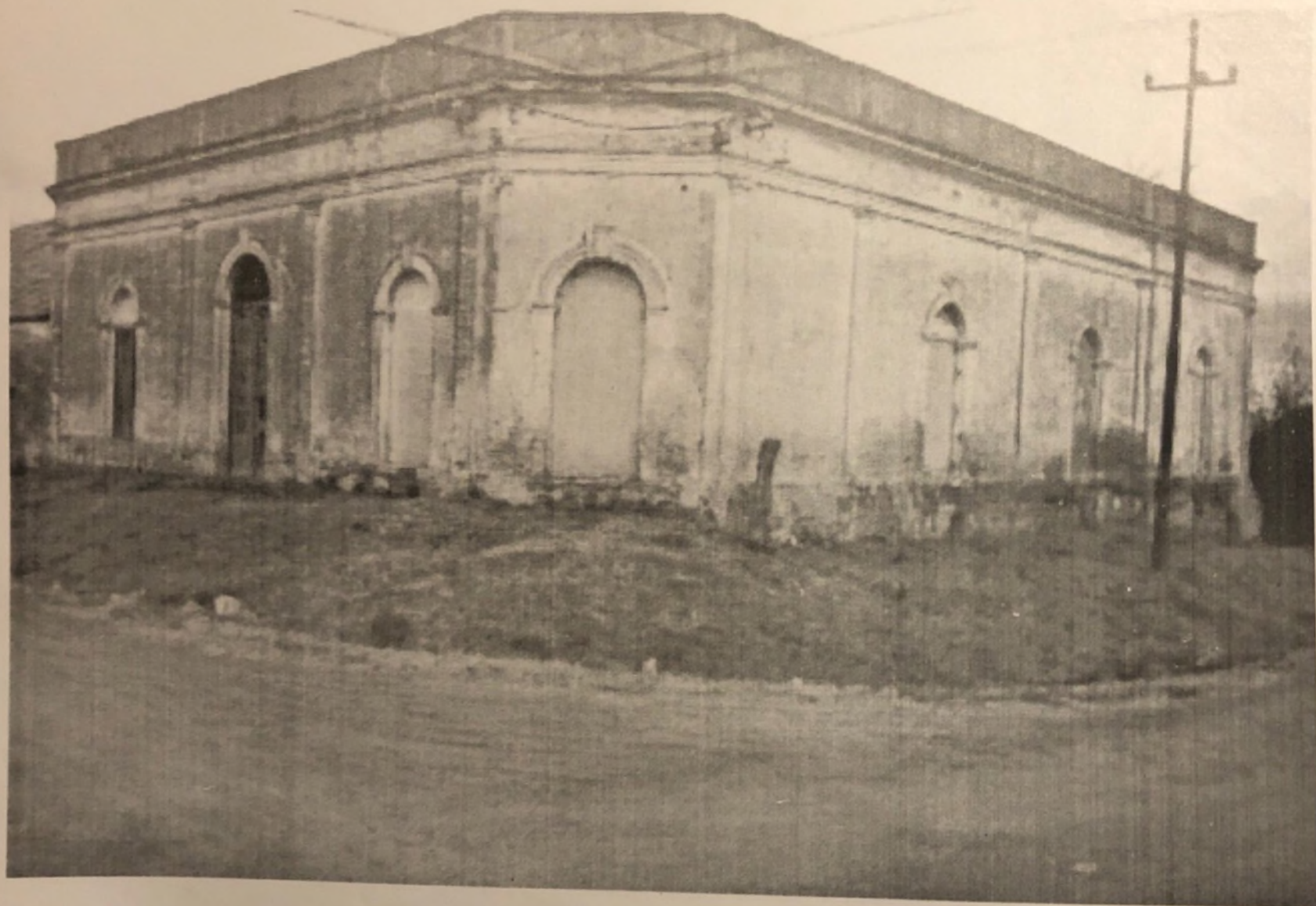
Edificio ubicado en las calles José E. Rodó y Sur, construida a fines del siglo XIX, funcionó por mucho tiempo la «Barraca Alemana» de Juan Schmidt.
