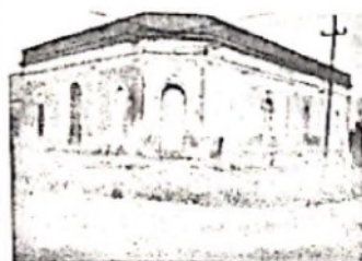
Fotografía de la fachada del edificio ubicado en calles José E. Rodó y Sur, construido a fines del siglo XIX, donde funcionó la «Barraca Alemana».
