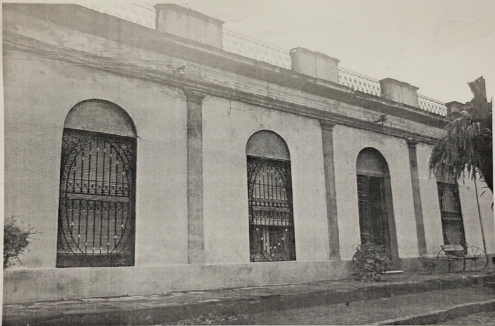
Edificio ubicado en las calles Dr. Murguía, esquina Pbro. Eloy García (Nueva Palmira) Casa que fuese de la flia. Corbacho, y donde funcionó en sus primeros años el Banco República.
