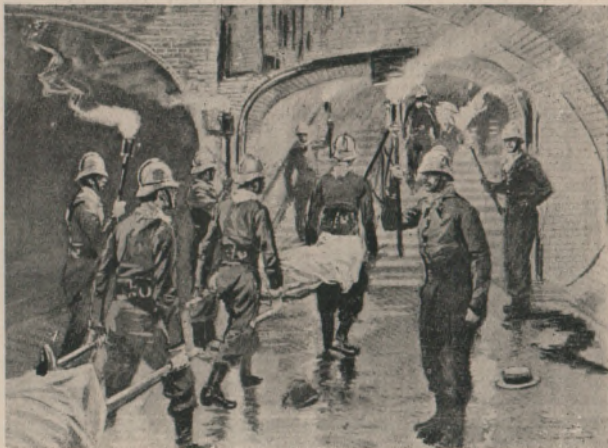
La conducción de los cadáveres á la estación de las Coronas
