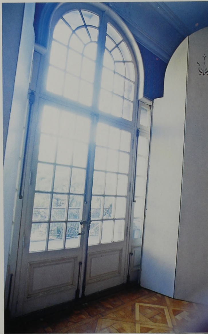
[096] Ventana y persiana interior de seguridad. Dormitorio principal.
