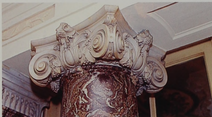
[055] Capiteles jónicos de las columnas.
