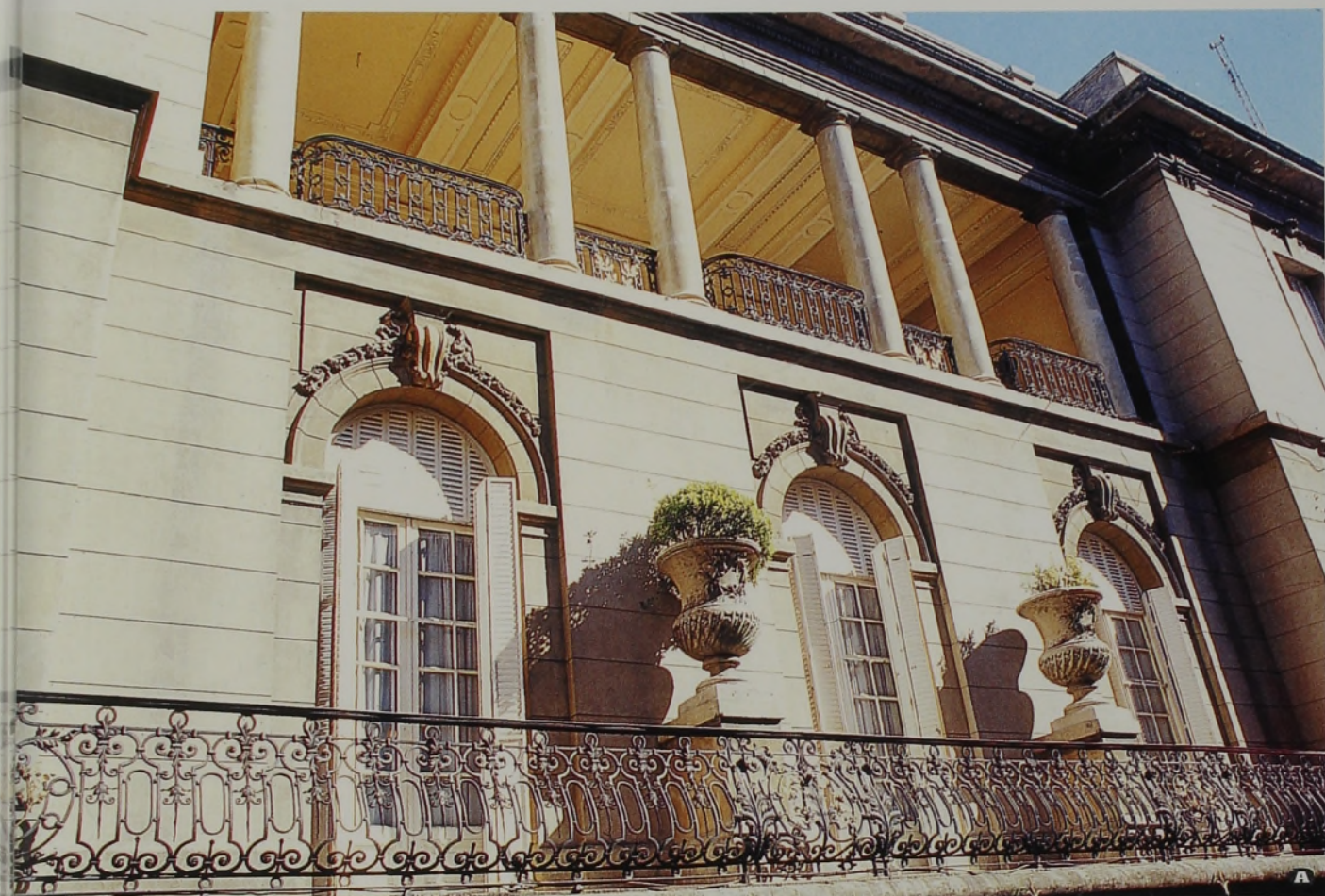
[077] a) Balcones de la fachada 25 de Mayo. Hierro forjado. b) Balcón de hierro, hacia el jardín.
