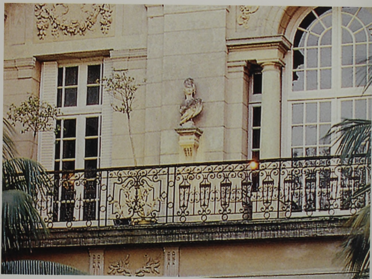
[093] Puertas y ventanas del balcón central, hacia el jardín.
