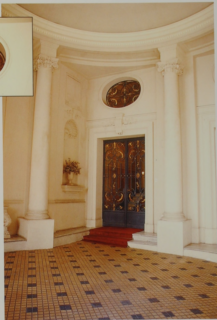
[071] Puerta de la entrada principal a la casa desde la rotonda cubierta. Casa Schwartz.
