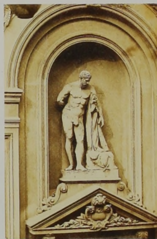
[050] Portada de los depósitos de Taranco y Cía en la calle Cerrito, exhibiendo la estatua de Hércules, distintivo comercial de la firma. Edificio obra de Juan Adams.
