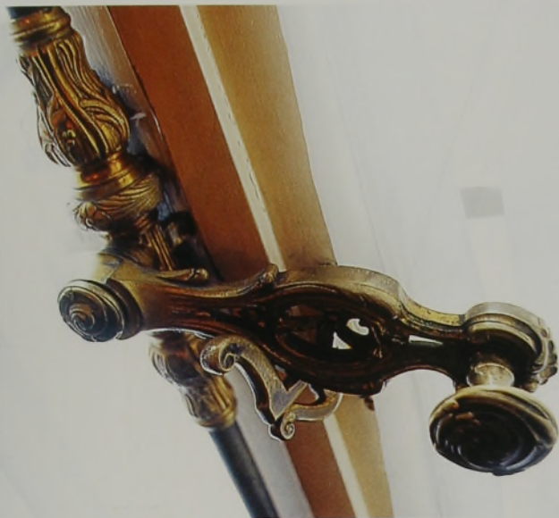
[086] Herrajes. Casa Bricart. Nótese el original mecanismo de cierre.
