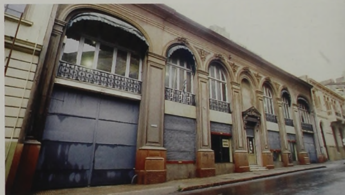
[024] Foto de las oficinas y depósitos de Taranco y Cía, en la calle Cerrito, en donde instalaron el almacén los hermanos Ortiz de Taranco después que vendieran la casa de 25 de Mayo y Zabala al Banco Español. La obra fue construida por don John Adams. Muchos años después fue adquirida por Metzen y Sena.
