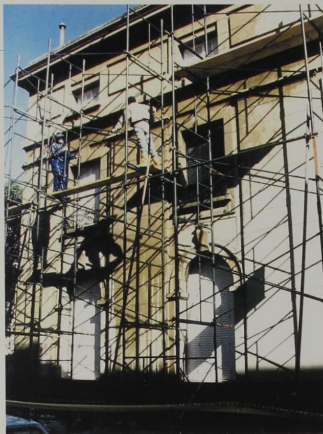
[258] Obras restauración Lezica y Ferrari. Fachada 1º de Mayo.
