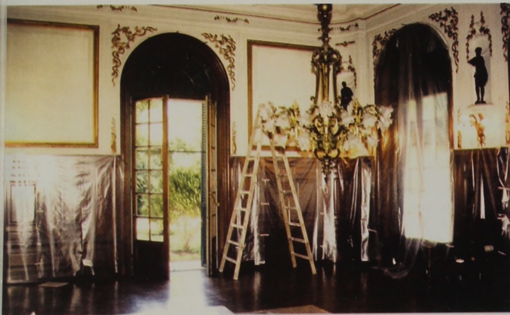
[263] Restauración del Comedor. Nótese la ausencia de los tapices de Aubusson, que fueron retirados para su limpieza.
