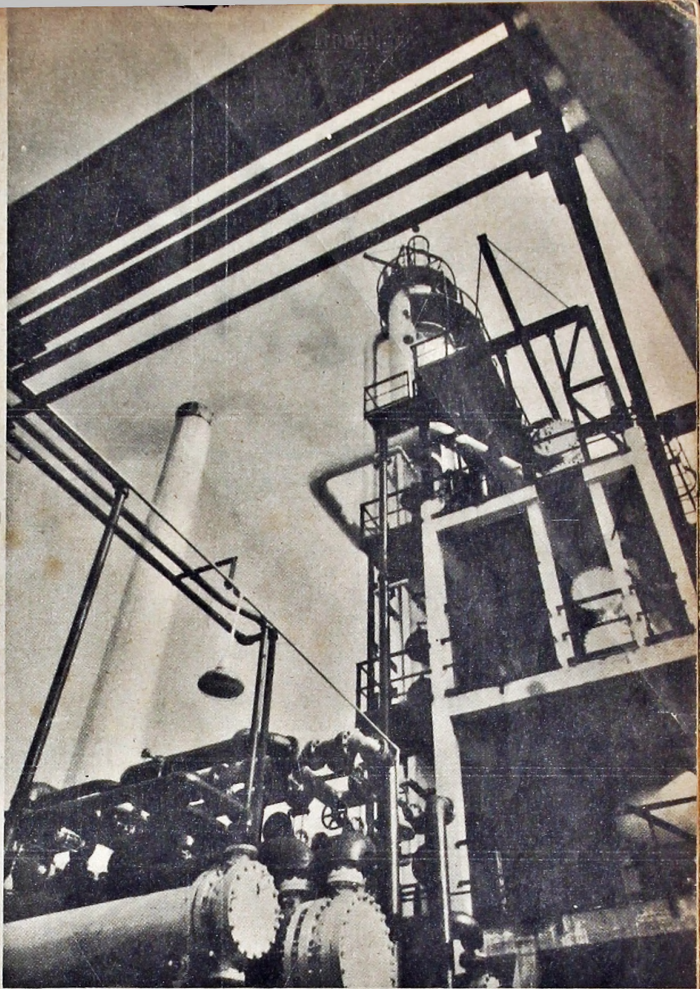
Vista parcial de la magnífica maquinaria de la Planta Industrial de la ANCAP
