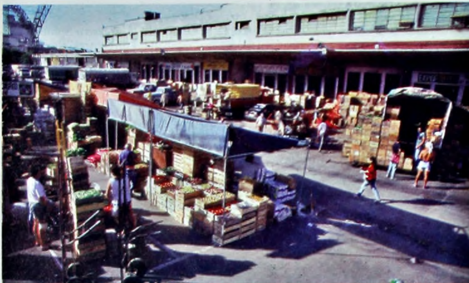
Spinoglio anunció a la Junta que, según informe de Ingeniería, la estructura que resistió el incendio está apta para ser reparada.
