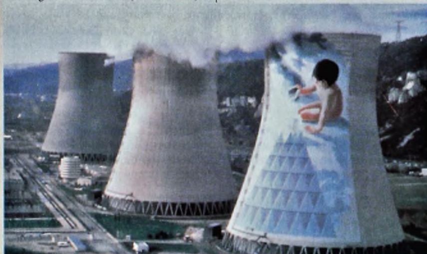
Una central atómica "autopublicitada" en Francia. El gigantesco fresco del pintor Jean Marie Pierret, sobre una torre autorrefrigerante, alude a la cantidad de aire "descontaminado" de la planta nuclear.
