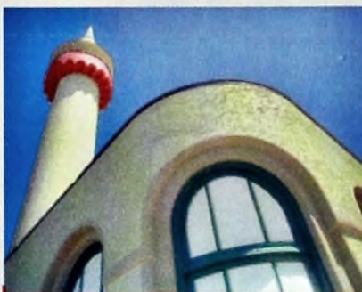
Para la construcción se trajo materiales del exterior, en especial del viejo continente, todos de primera calidad.
