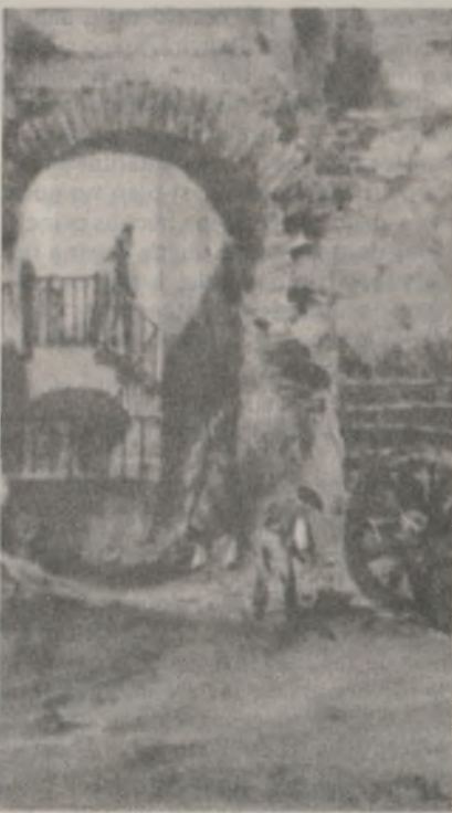
Muros ruinosos en un país en ruinas. (Acuarela de D' Hastrel, mostrando la muralla e interior de la Ciudadela).
