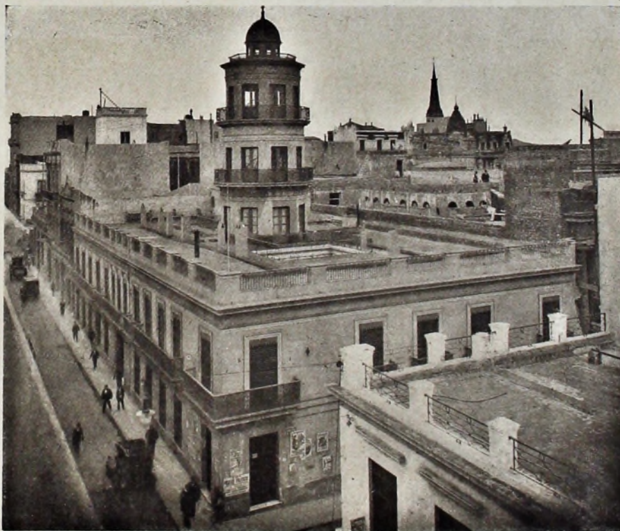
VISTA EXTERIOR DE LA CASA PATRICIA
