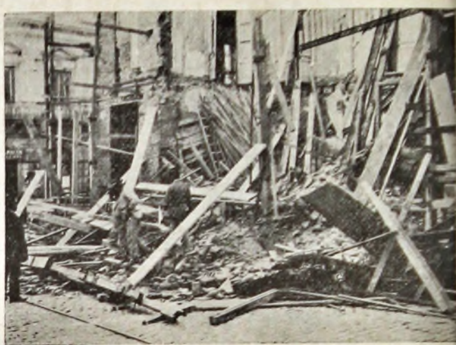
Removiendo los escombros en busca de las víctimas
