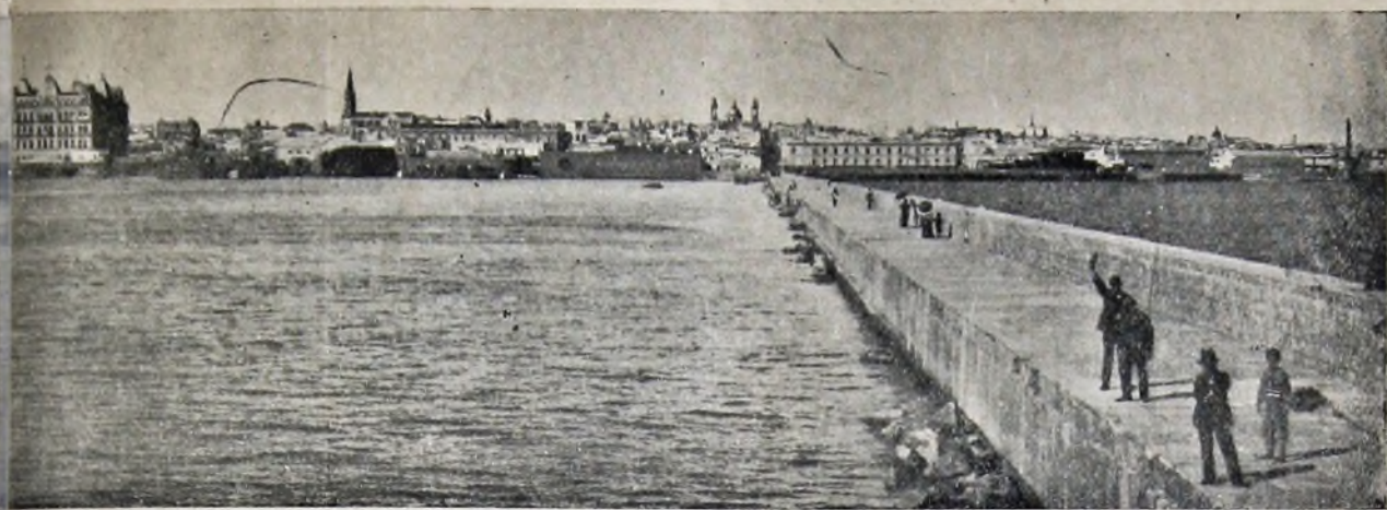
La escollera terminada
