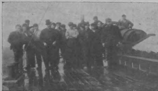
La tripulación sobre cubierta
