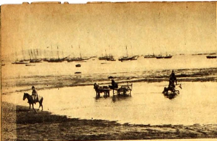
Aspecto del "boquete" en una bajante. (Foto de Barreira Villamil, 1899).
