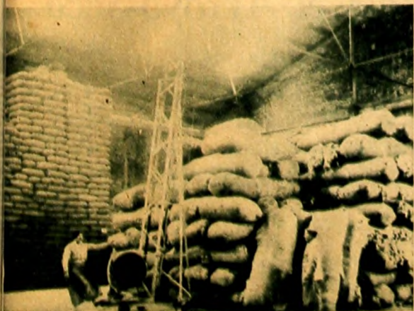
Un sector interior de la barraca.
