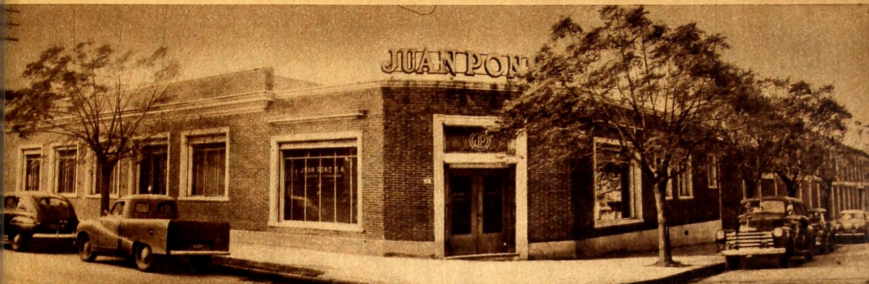
El moderno edificio de la barraca y aserradero Juan Pons.
