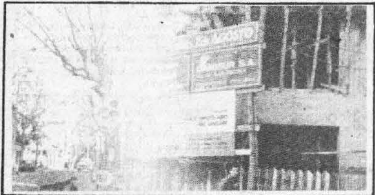
LIBERTAD DE PRENSA. Sugestivo nombre lleva este edificio en construcción en Montevideo. Ideal para instalar dependencias ministeriales del actual Proceso que se hagan cargo del control a la Prensa.
