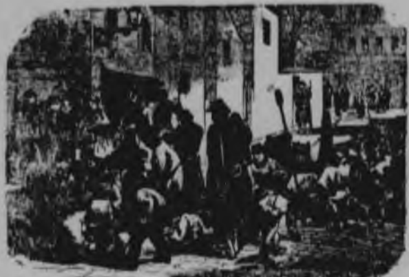
Construyendo una barricada
