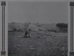
La avenida de 40 metros de ancho que conduce de Las Piedras al monumento.
