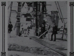
El monumento de Las Piedras, en construcción
