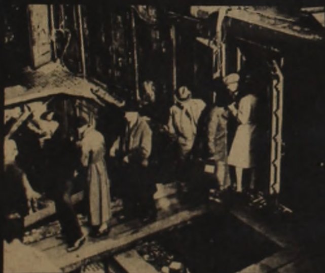
Vase a que este edificio de un banco londinense fué terriblemente bombardeado, el lugar de las cajas fuerte quedó intacto, como puede apreciarse por esta foto. Los clientes, encantados! (I. News)
