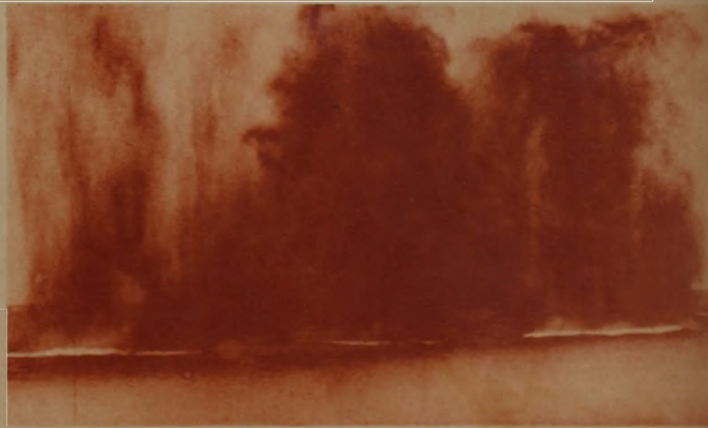
Los aviones italianos atacaron a un convoy británico en el Mediterráneo dejando caer centenares de poderosas bombas sobre el mismo y creando escenas de fuerza dantesca como la que representa esta nota, captada por la cámara cinematográfica. Pero ni una de las bombas dió en el blanco y el convoy llegó felizmente a destino. (British Olympic News).
