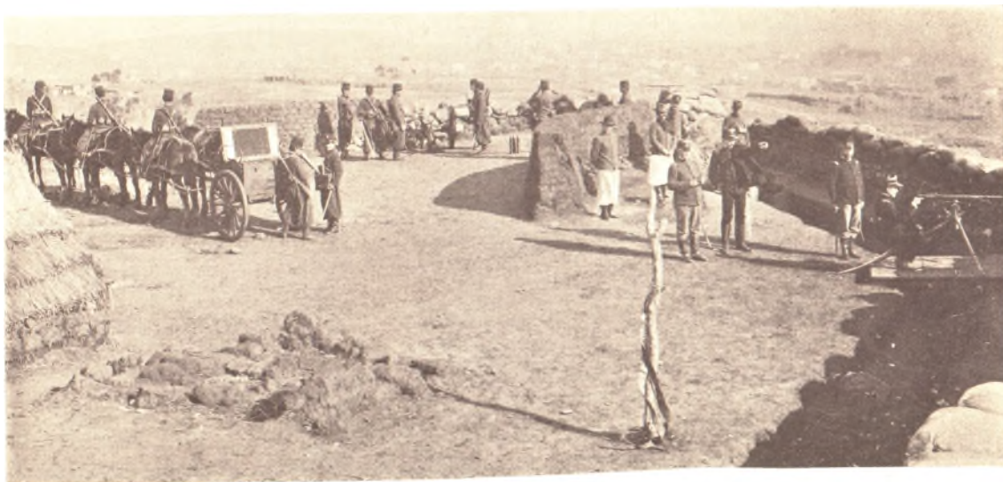
INTERIOR DE LAS FORTIFICACIONES
