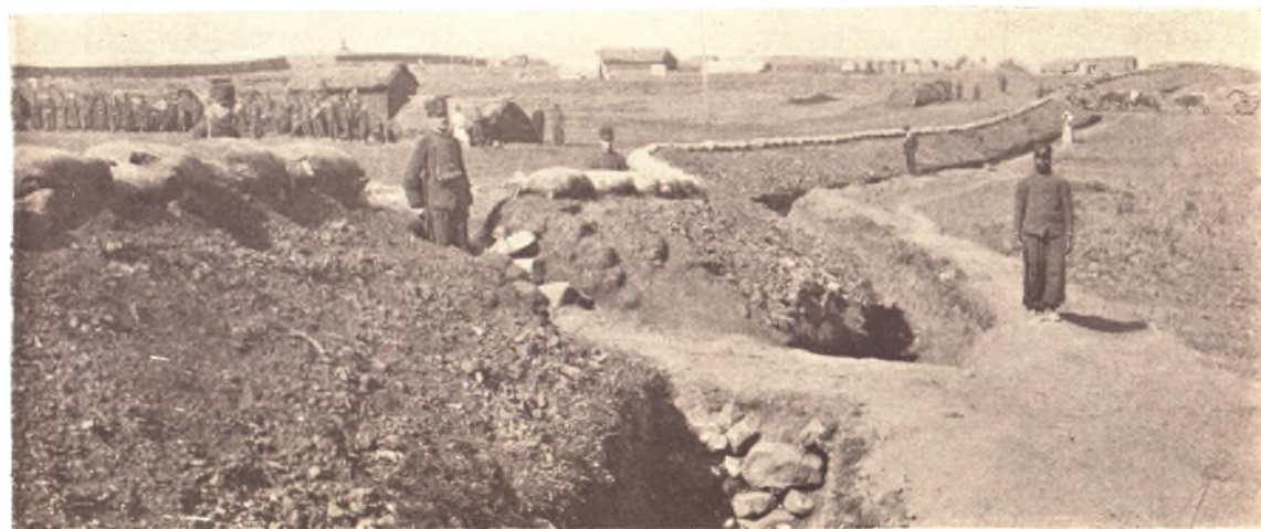
OTRA PARTE DE LAS FORTIFICACIONES
